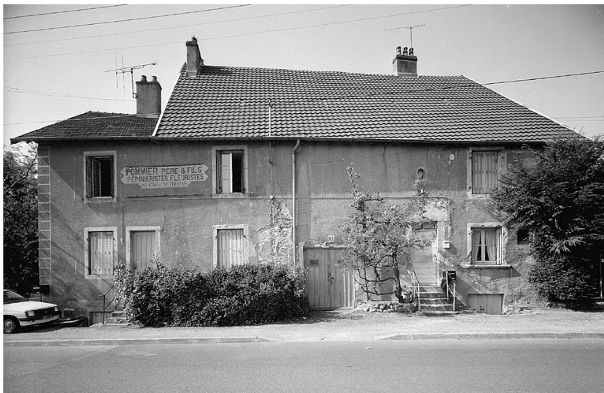
Façade antérieure, de face.
