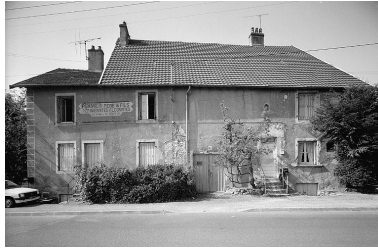
Façade antérieure, de face. Phot. Yves Sancey IVR43_19917000289V
