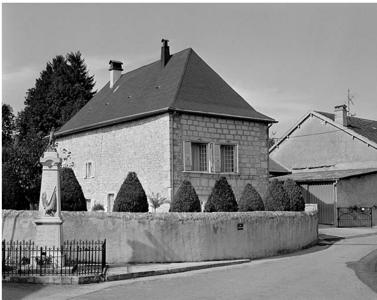
Vue générale depuis la rue Gambetta.
