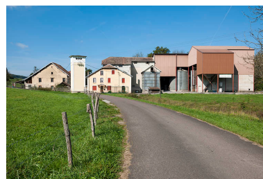
Vue depuis la route d'accès. Phot. Jérôme Mongreville IVR43_20142501638NUC4A
