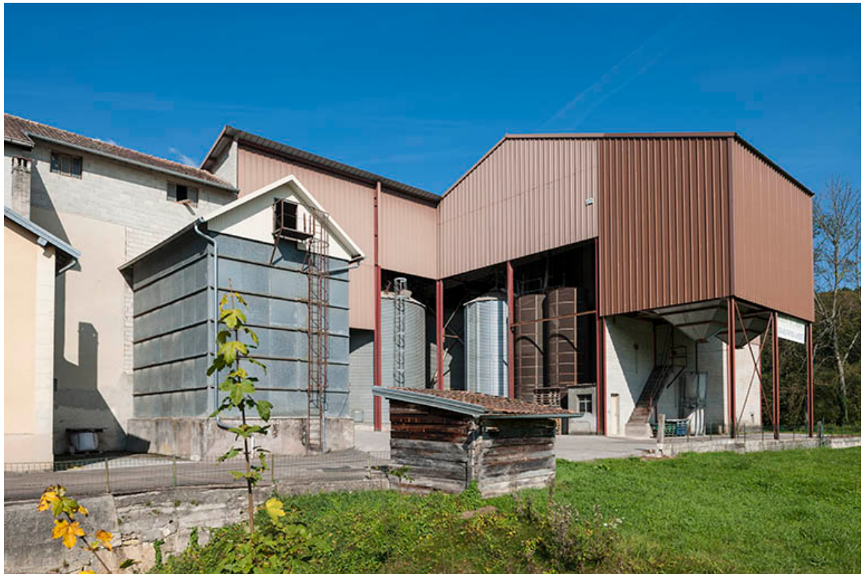
Silos à blé et pont bascule.
