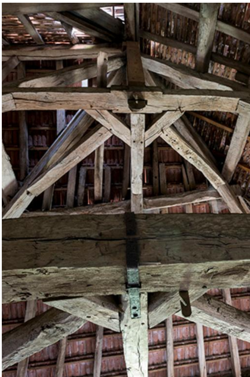
Poutrage du grenier de la chapelle
