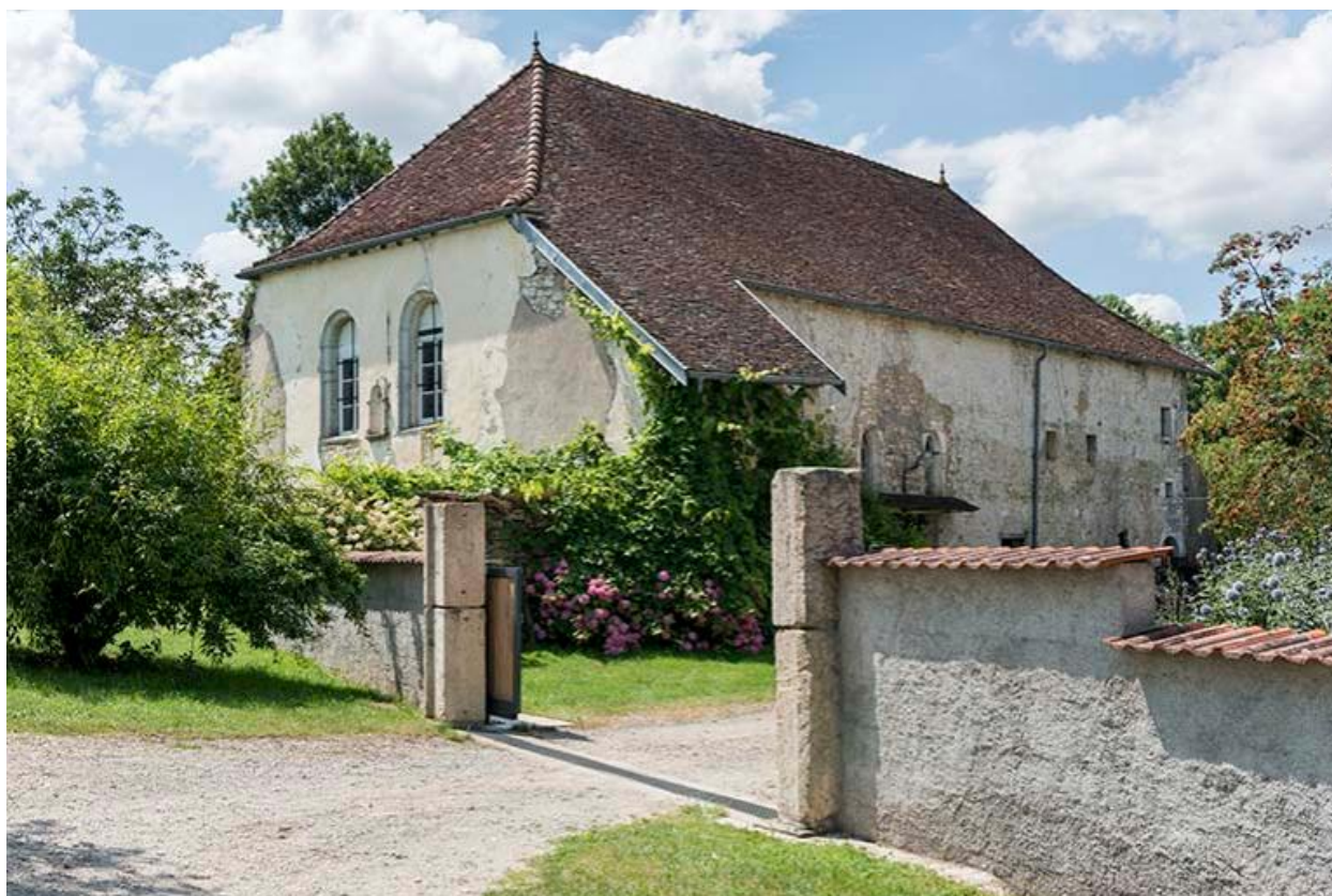
Vue de la chapelle, côté cour
