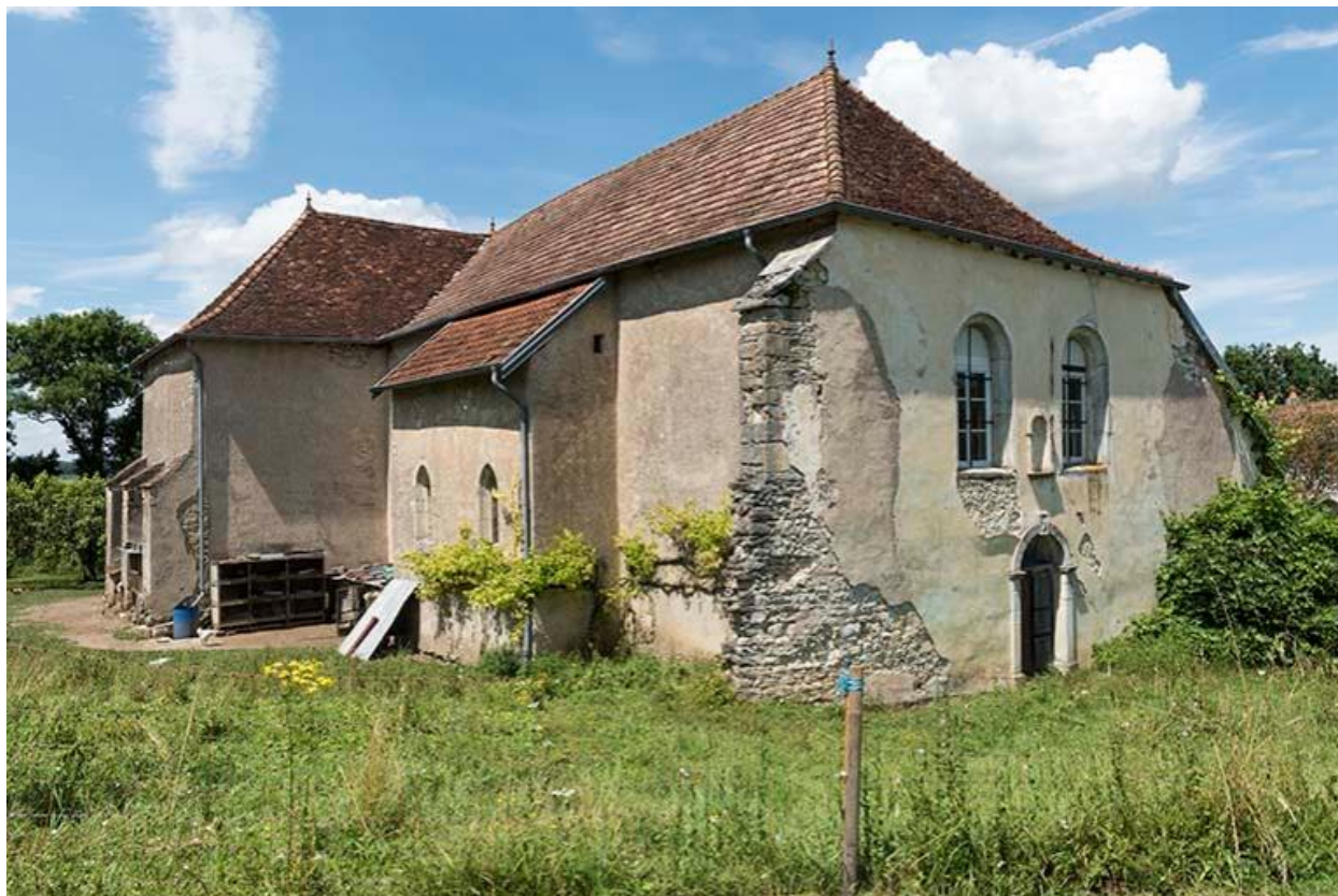
Vue d'ensemble de la chapelle
