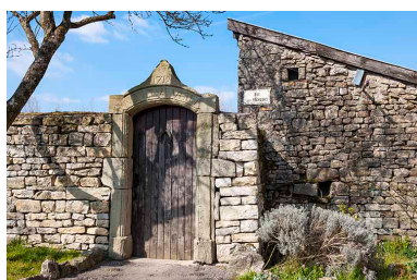
Porte d'accès au jardin de l'ancien presbytère. Phot. Jérôme Mongreville IVR43_20167000499NUC4A
