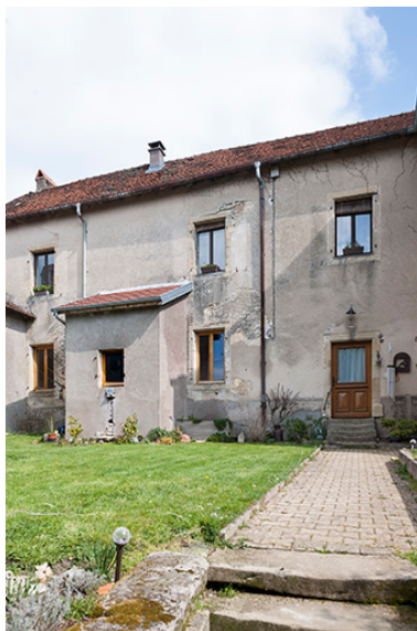
La façade antérieure. Phot. Jérôme Mongreville IVR43_20167000467NUC4A
