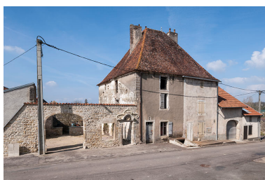
Vue d'ensemble. Phot. Jérôme Mongreville IVR43_20167000441NUC4A
