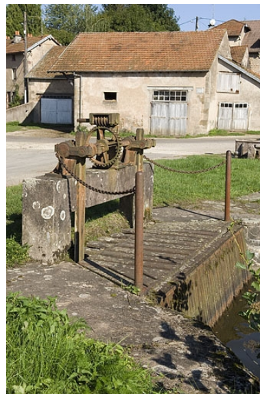
Vanne de prise d'eau de l'étang. Phot. Jérôme Mongreville IVR43_20067000751NUCA
