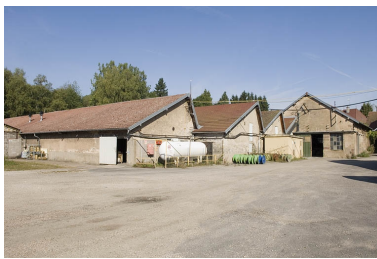
Ateliers de fabrication en rez- de-chaussée depuis le sud. Phot. Jérôme Mongreville IVR43_20097000861NUC2A
