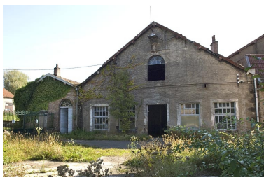
Pignon de l'atelier de réparation. Phot. Jérôme Mongreville IVR43_20097000865NUC2A
