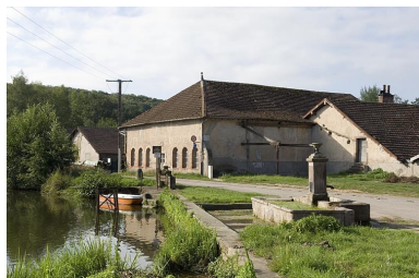
Prise d'eau de l'étang et ateliers est. Phot. Jérôme Mongreville IVR43_20067000746NUCA
