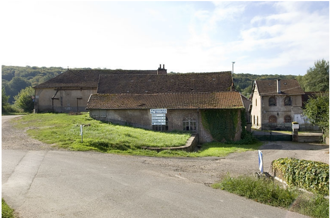
Les bâtiments à l'entrée de l'usine.
