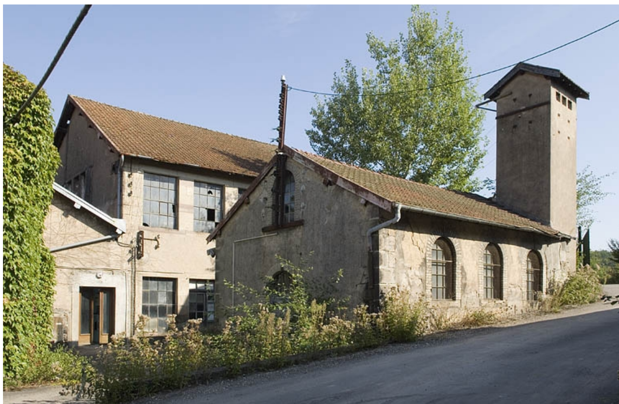
Local technique et transformateur électrique à l'entrée.
