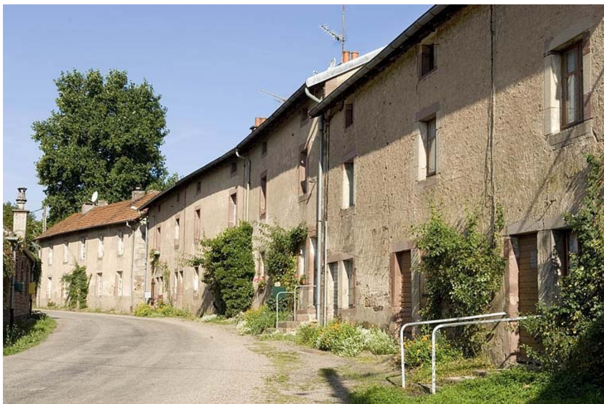
Façades de logements ouvriers (R.D. 304).
