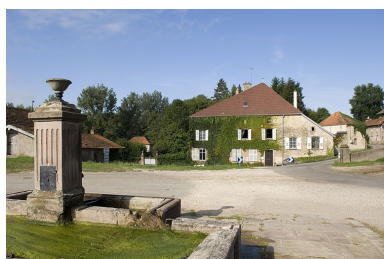
Place des Forges et logement patronal. Phot. Jérôme Mongreville IVR43_20067000747NUCA
