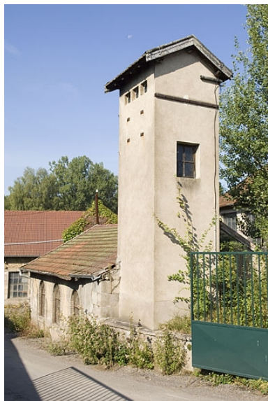
Le transformateur électrique depuis l'entrée. Phot. Jérôme Mongreville IVR43_20097000860NUC2A
