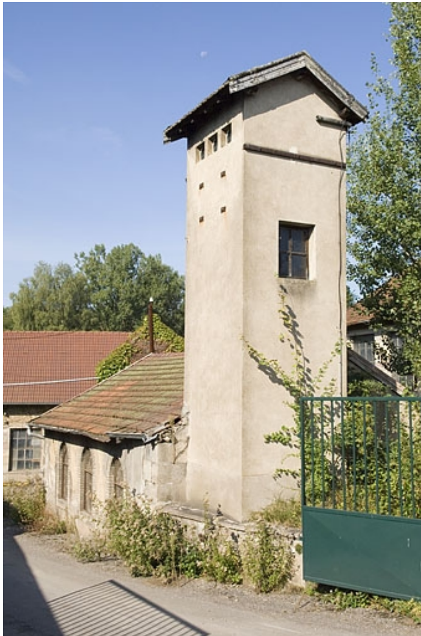
Le transformateur électrique depuis l'entrée.
