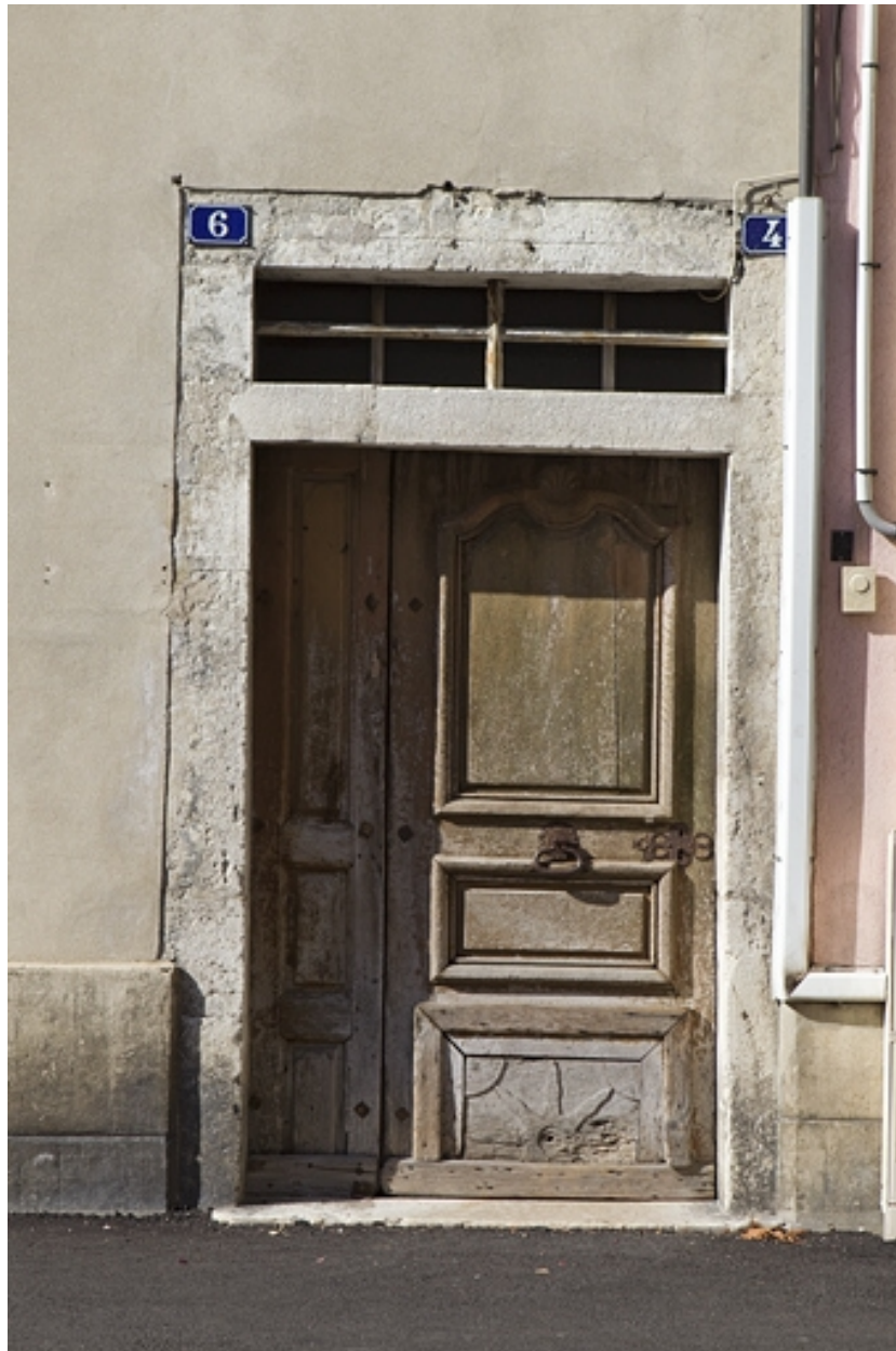
Porte principale sur la rue Merlin.
