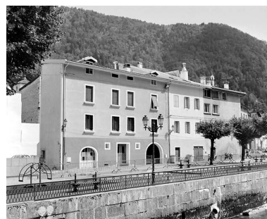
Vue d'ensemble sur la rue des Promenades. Phot. Yves Sancey IVR43_20033900706X
