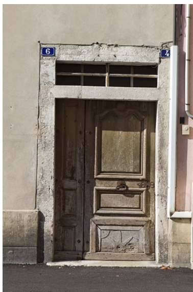
Porte principale sur la rue Merlin. Phot. Yves Sancey IVR43_20103900594NUC2A
