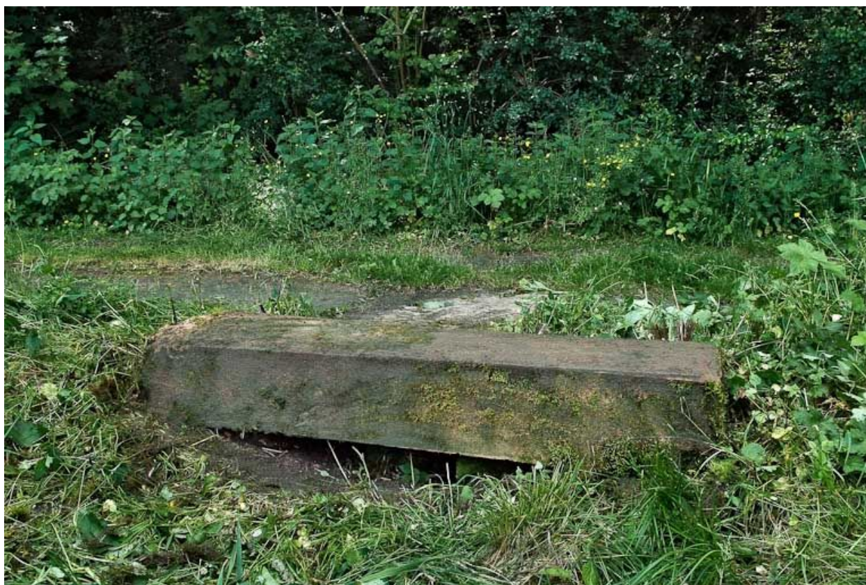
Linteau restant du pont des Freteurs.
