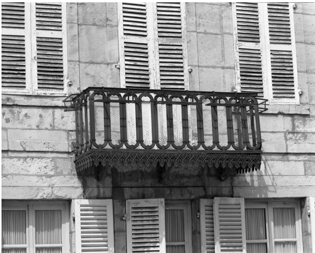
Façade antérieure : détail du balcon en ferronnerie.
