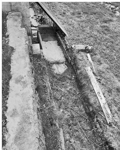
Canal d'amenée d'eau sur la roue ou " arrivoir ". Phot. Jérôme Mongreville IVR43_20003900139X
