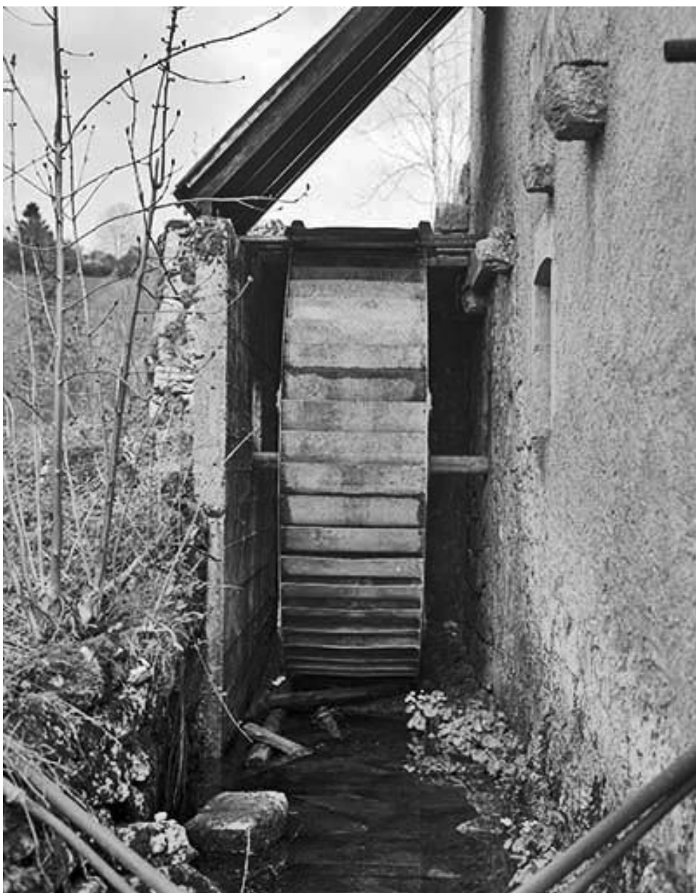
Roue à aubes ou à " augets ".
