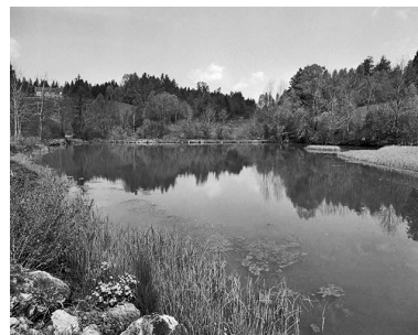
Bassin de retenue d'eau. Phot. Jérôme Mongreville IVR43_20003900142X
