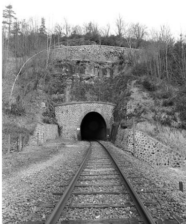
Tunnel : tête côté La Cluse (sud).
