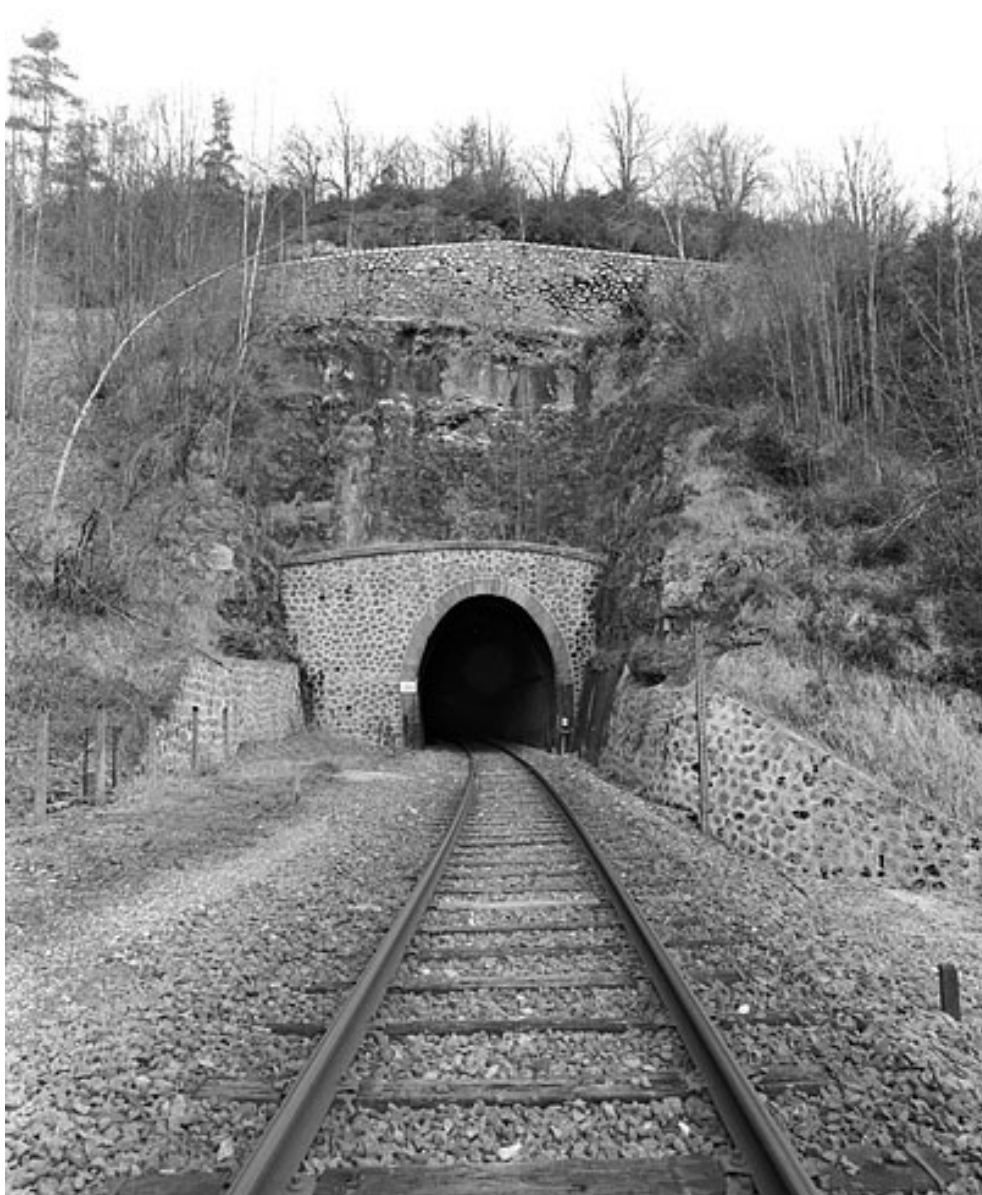
Tunnel : tête côté La Cluse (sud).
