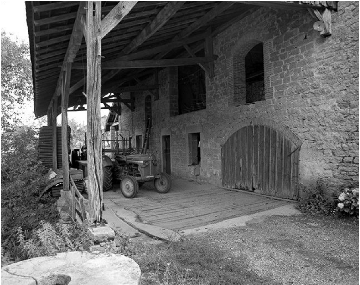
Façade antérieure, partie gauche.
