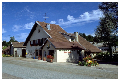
Vue d'ensemble. Phot. Yves Sancey IVR43_19973901453ZA
