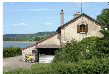
Elévation postérieure. Phot. Alain Morelière IVR26_20072106120NUC2A
