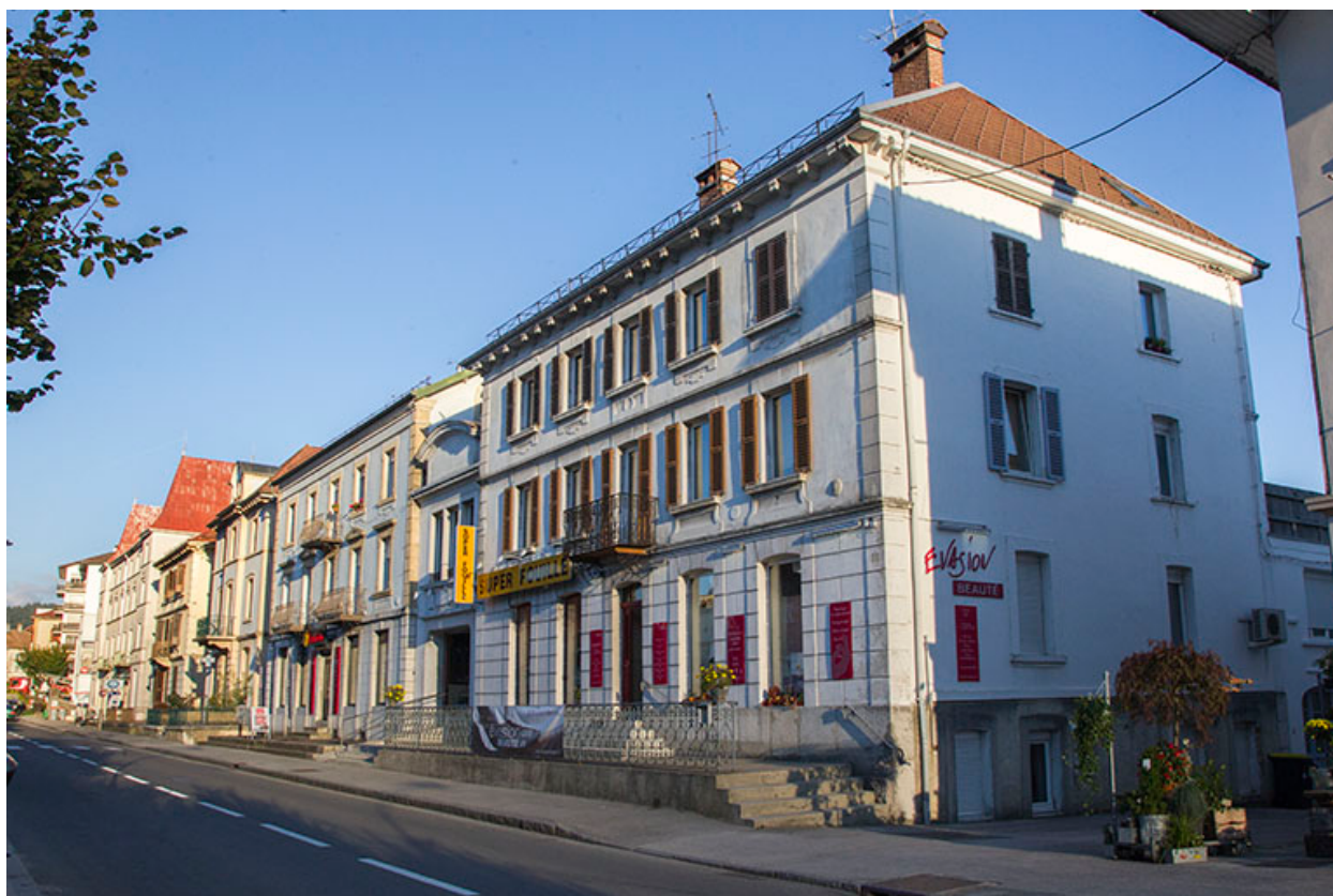
Vue d'ensemble, depuis l'ouest.
