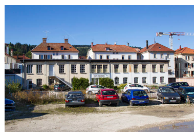
Atelier, depuis le sud. Phot. Yves Sancey IVR43_20132502370NUC2A
