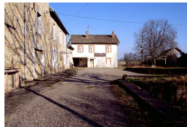
Vue depuis l'entrée. De gauche à droite : atelier de fabrication, logement patronal et parties agricoles, logement d'ouvriers, remise à automobile. Phot. Jérôme Mongreville IVR43_19963900013ZA
