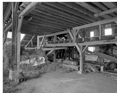
Intérieur de la scierie. Phot. Jérôme Mongreville IVR43_19963900025X
