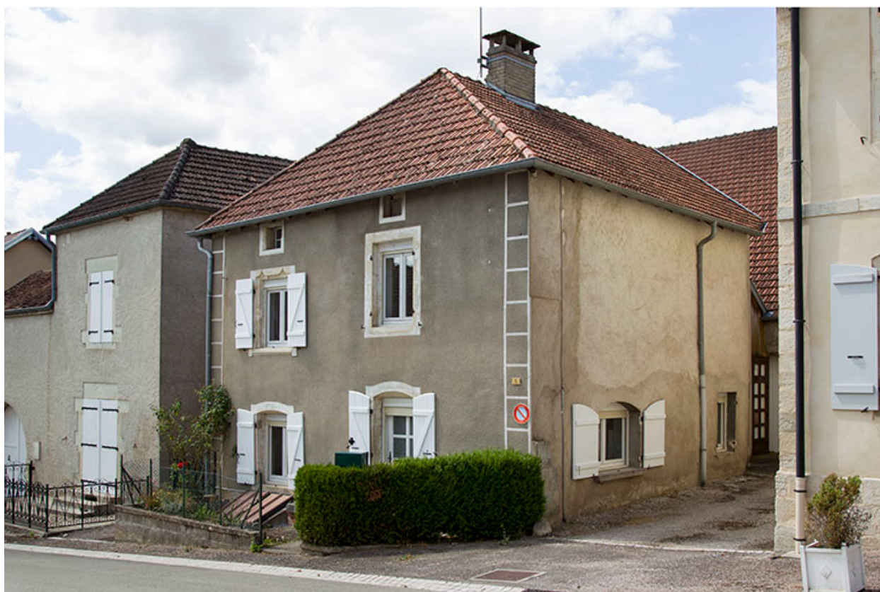
Vue générale de trois quart droite.
