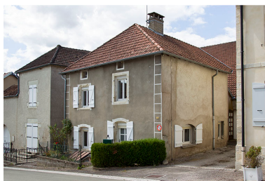
Vue générale de trois quart droite.
