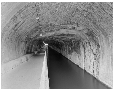
Intérieur, depuis la tête amont. Phot. Jérôme Mongreville IVR43_20032500159X
