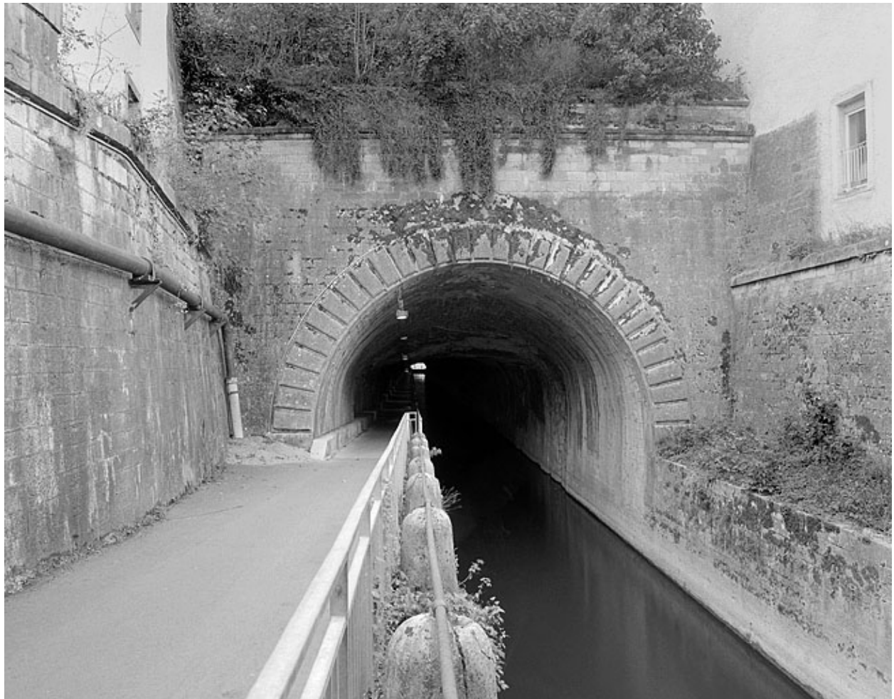
Tranchée et tête amont.
