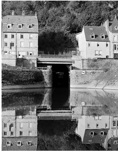
Porte de garde et extrémité amont. Phot. Jérôme Mongreville IVR43_20032500164X
