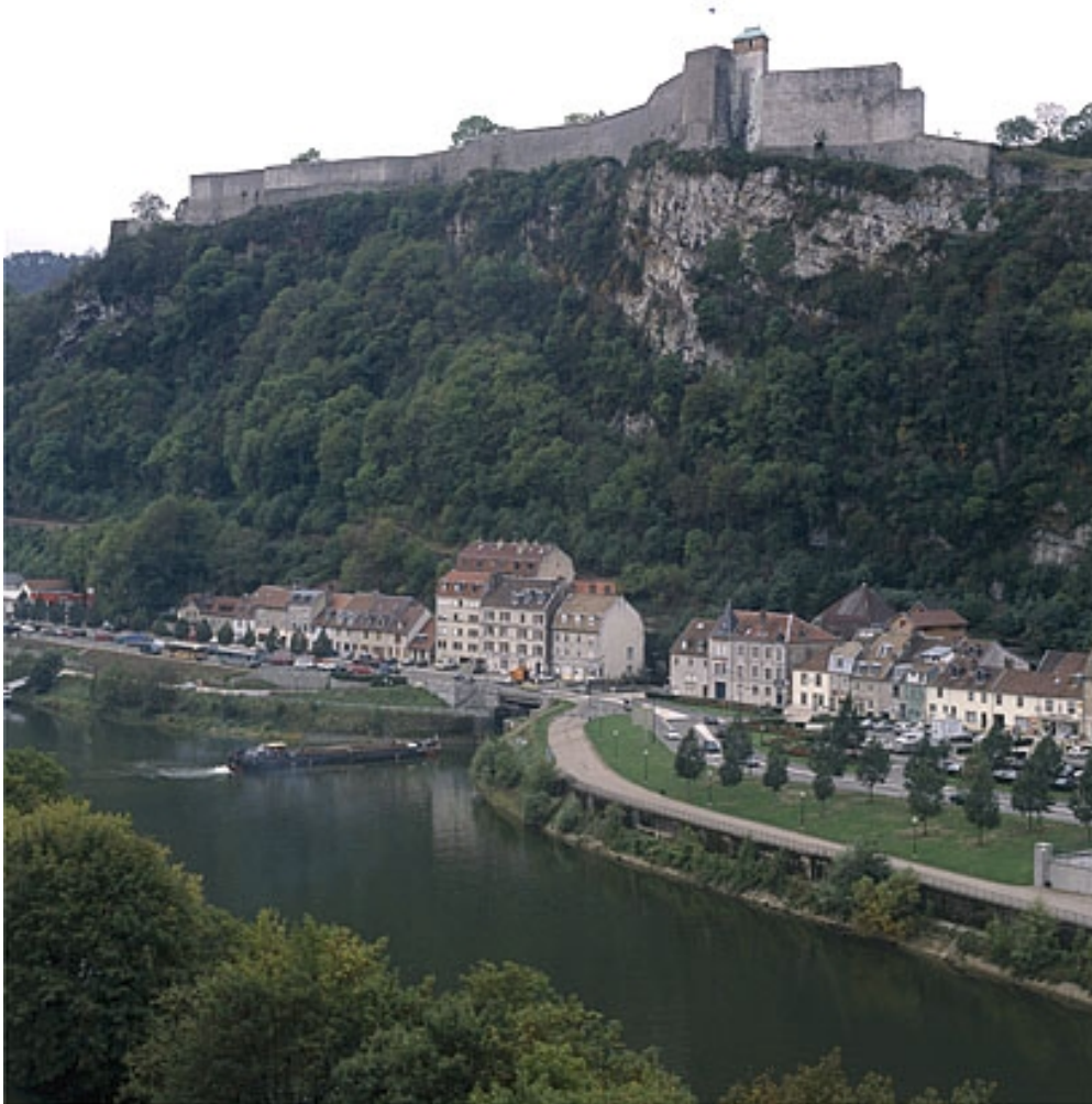
Vue d'ensemble plongeante sur l'extrémité amont.
