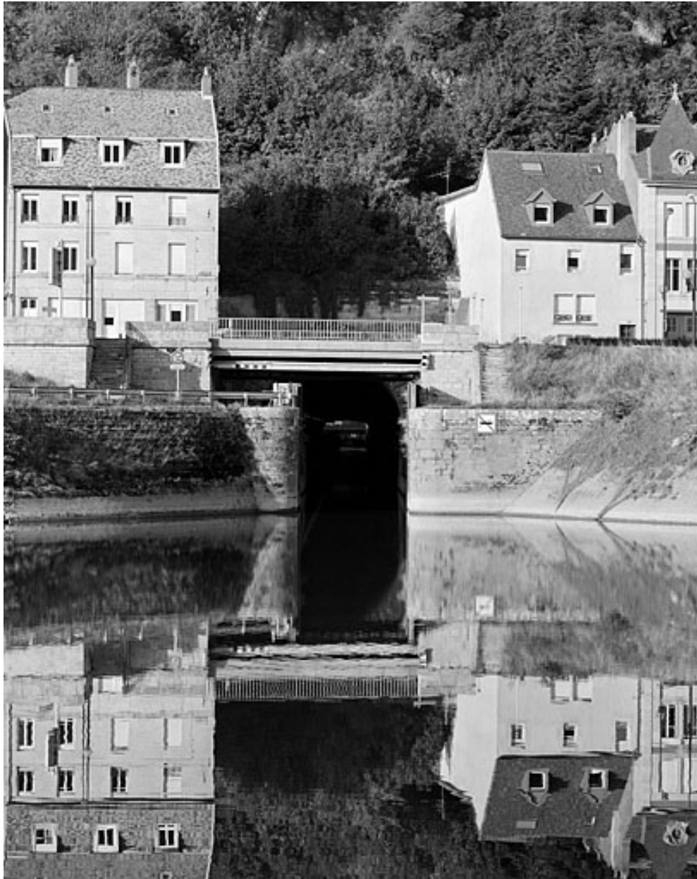
Porte de garde et extrémité amont.
