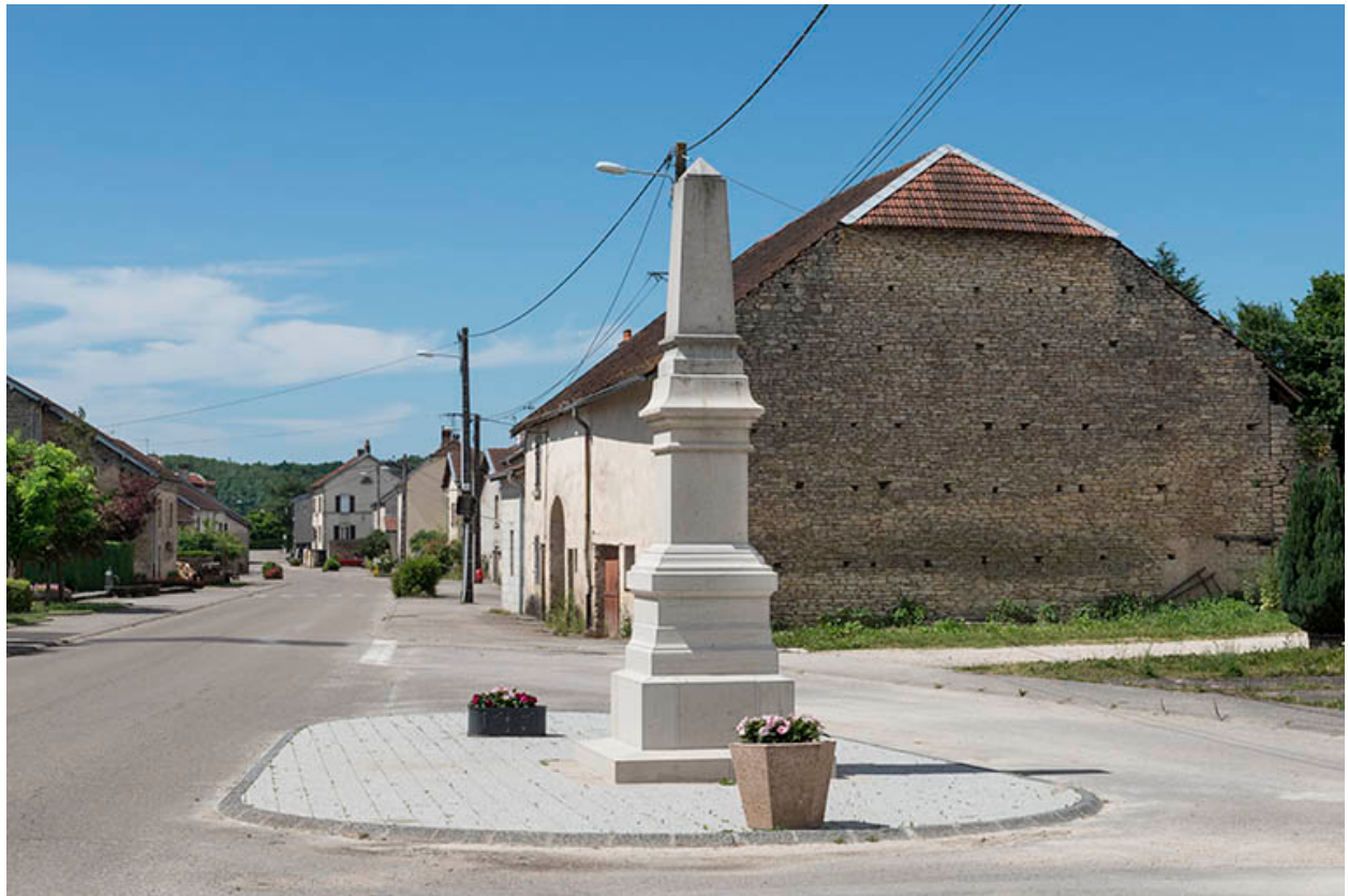
Vue d'ensemble, face postérieure.
