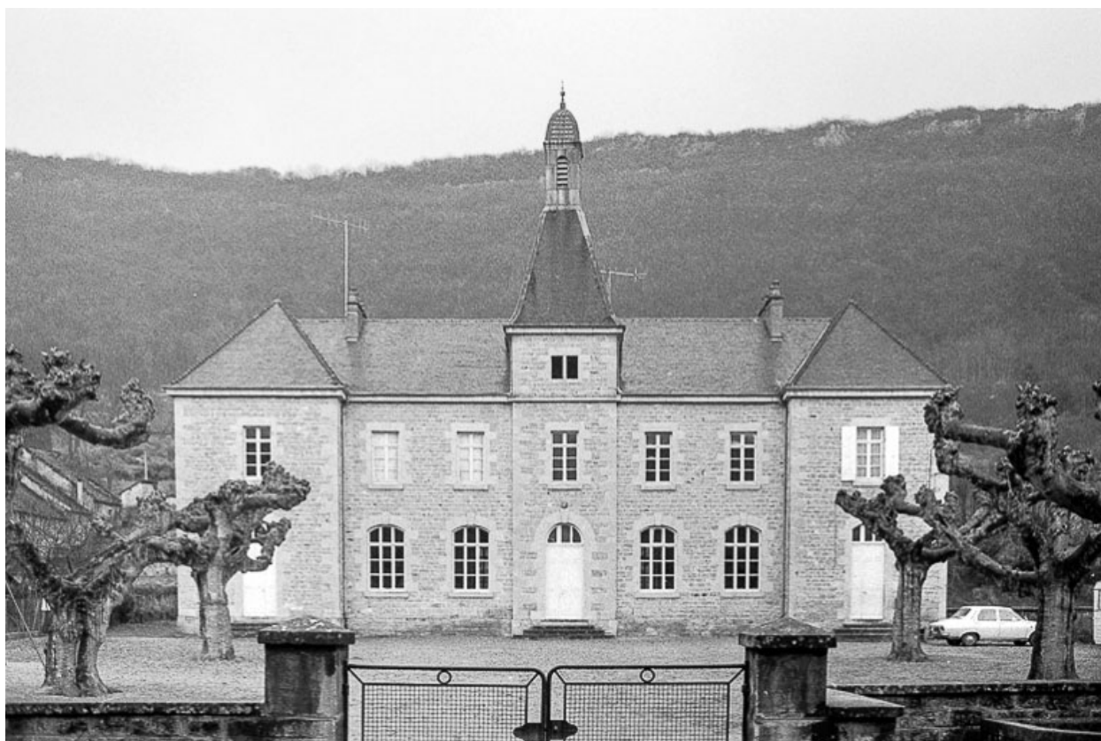
Mairie-école : façade antérieure.
