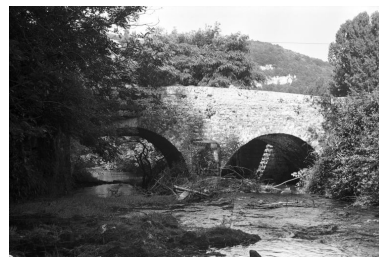
Pont situé route de la Vallée. Phot. Guy Forestier IVR43_19743900578Z
