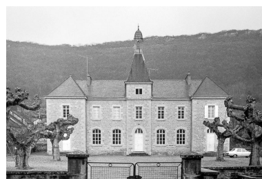
Mairie-école : façade antérieure.
