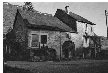
Maison cadastrée 1965 AD 105 : façade sud. Phot. F. Pernin IVR43_19743900158Z
