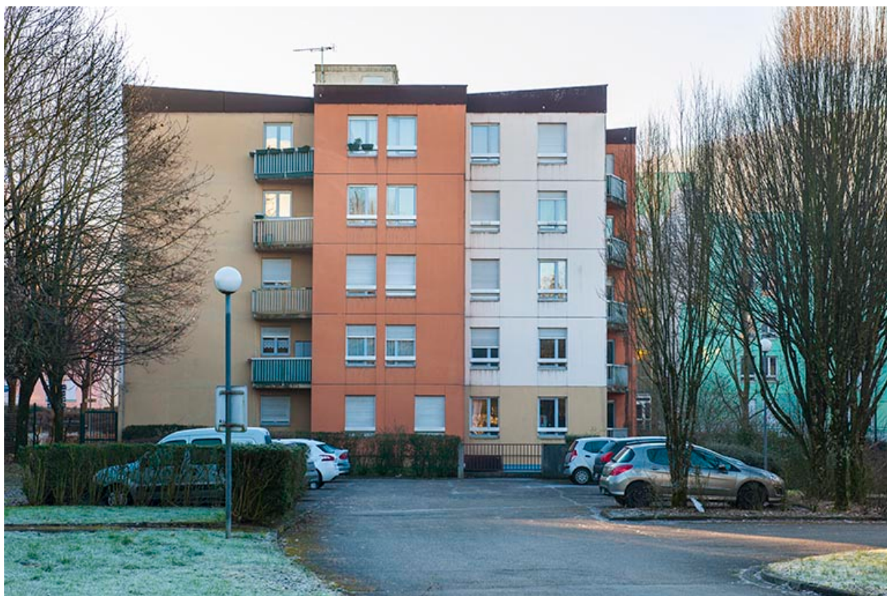
Les logements : façade nord-ouest.
