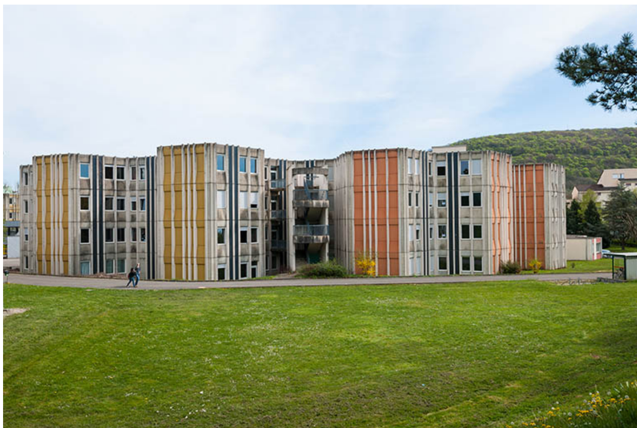
Vue d'ensemble des façades postérieures de l'internat.
