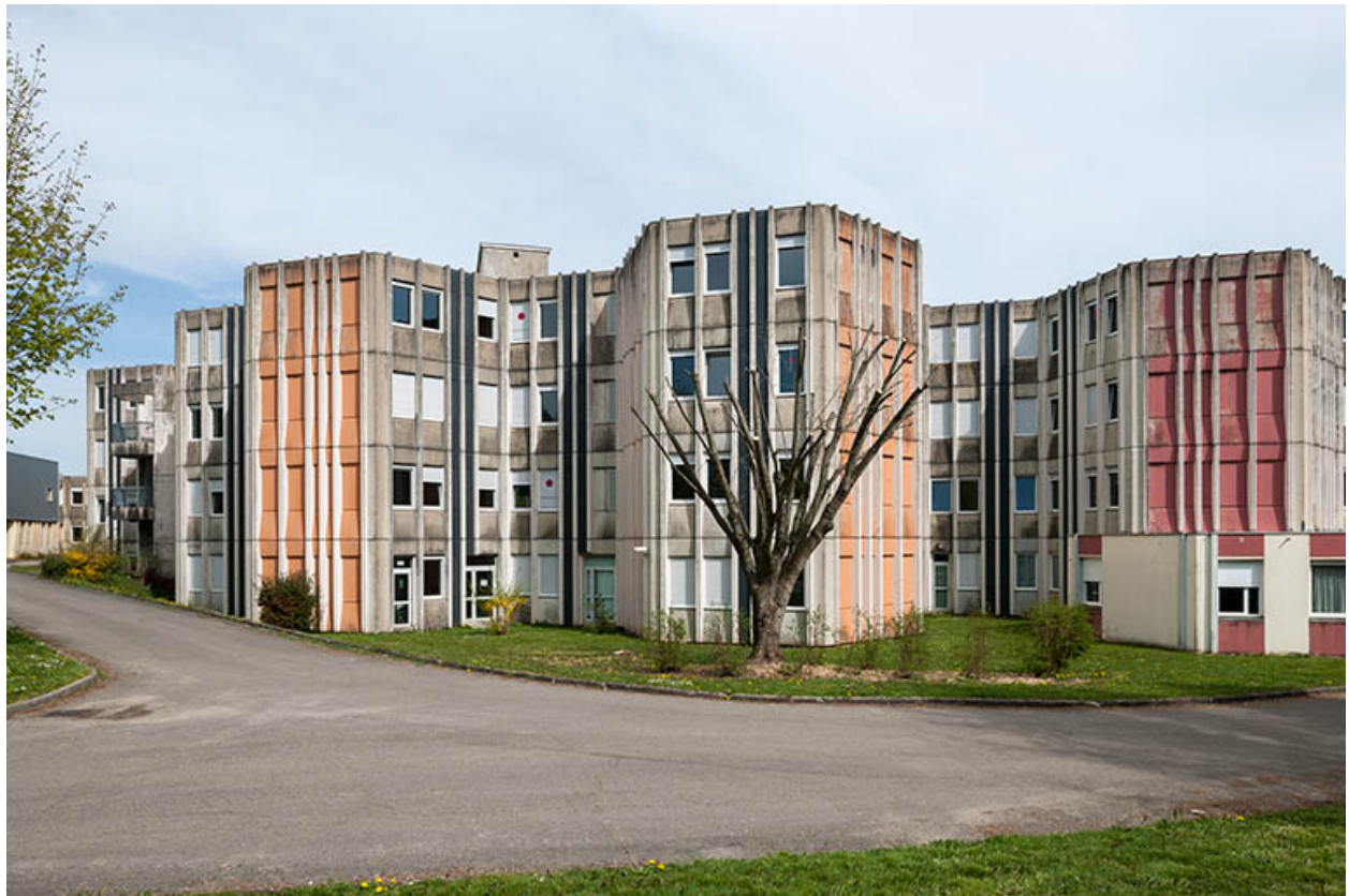
Les façades ouest de l'internat.
