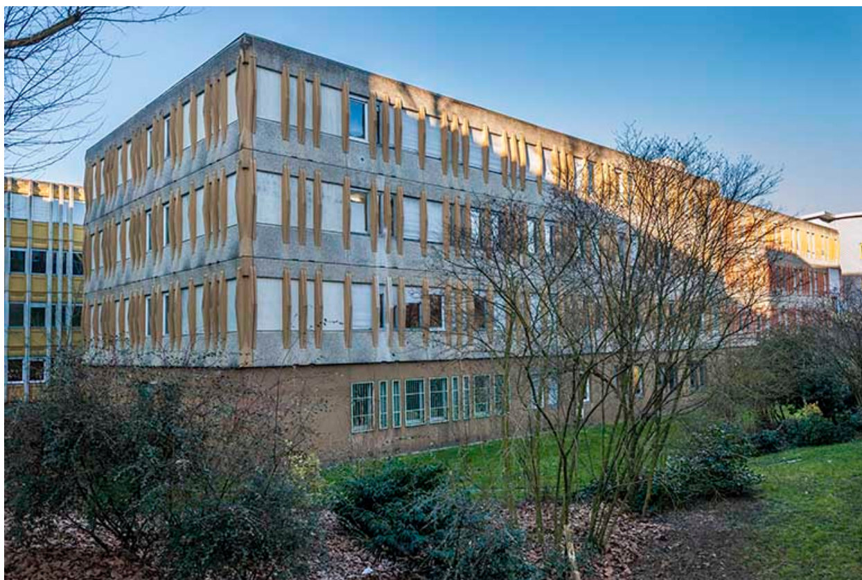
Angle sud-est de l'externat.
