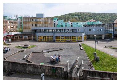
Face postérieure de l'œuvre de Jean Gilles, la cour et les façades nord-ouest de l'administration. Phot. Jérôme Mongreville IVR43_20142500357NUC4A
