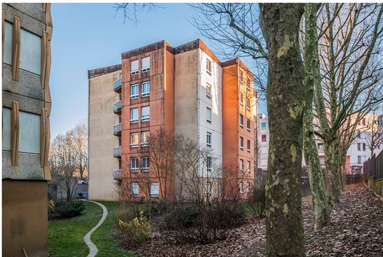
Angle sud des logements.
