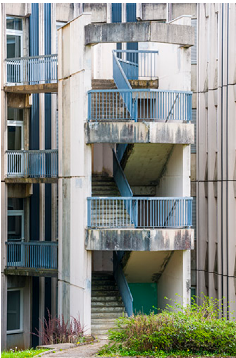
Détail de l'escalier extérieur de l'internat.
