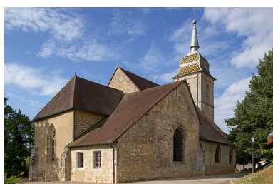
Le choeur et la façade latérale gauche. Phot. Sonia Dourlot IVR43_20157000439NUC2A
