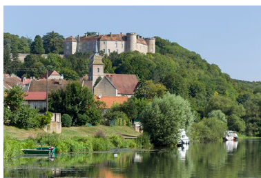
Vue générale depuis la Saône.
