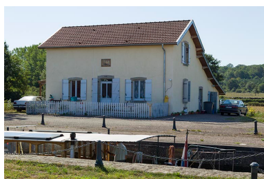
La maison d'éclusier. Phot. Sonia Dourlot IVR43_20157000727NUC2A
