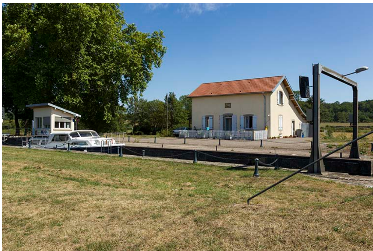
Le site d'écluse, vue d'ensemble.
