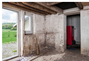
Cave en déblai. Phot. Jérôme Mongreville IVR43_20167000300NUC4A
