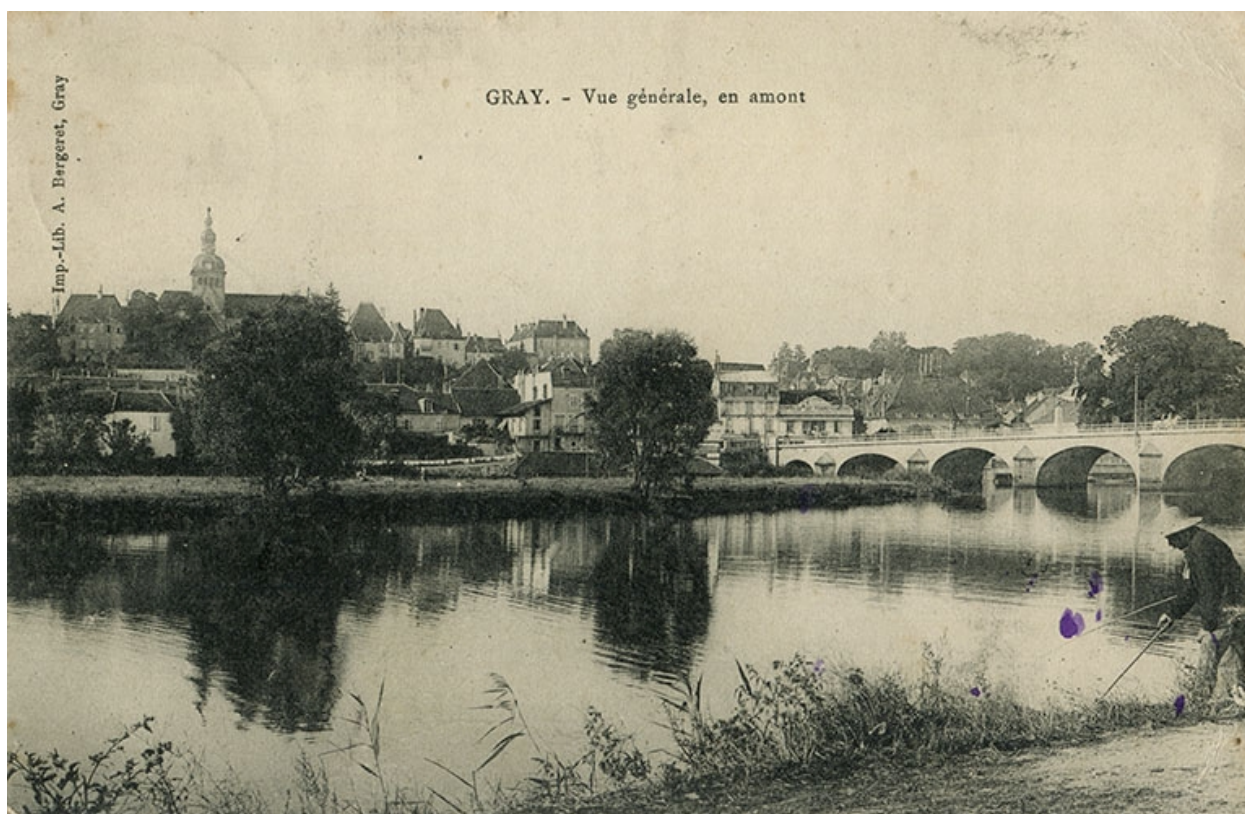
Vue générale en amont, carte postale.
