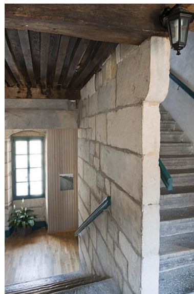
Intérieur : escalier principal en pierre, dernière volée. Phot. Jérôme Mongreville IVR43_20112500122NUC4A
