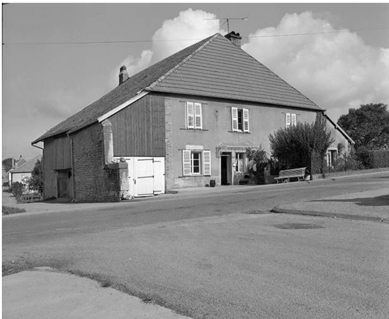
Façade antérieure vue de trois quarts gauche.
