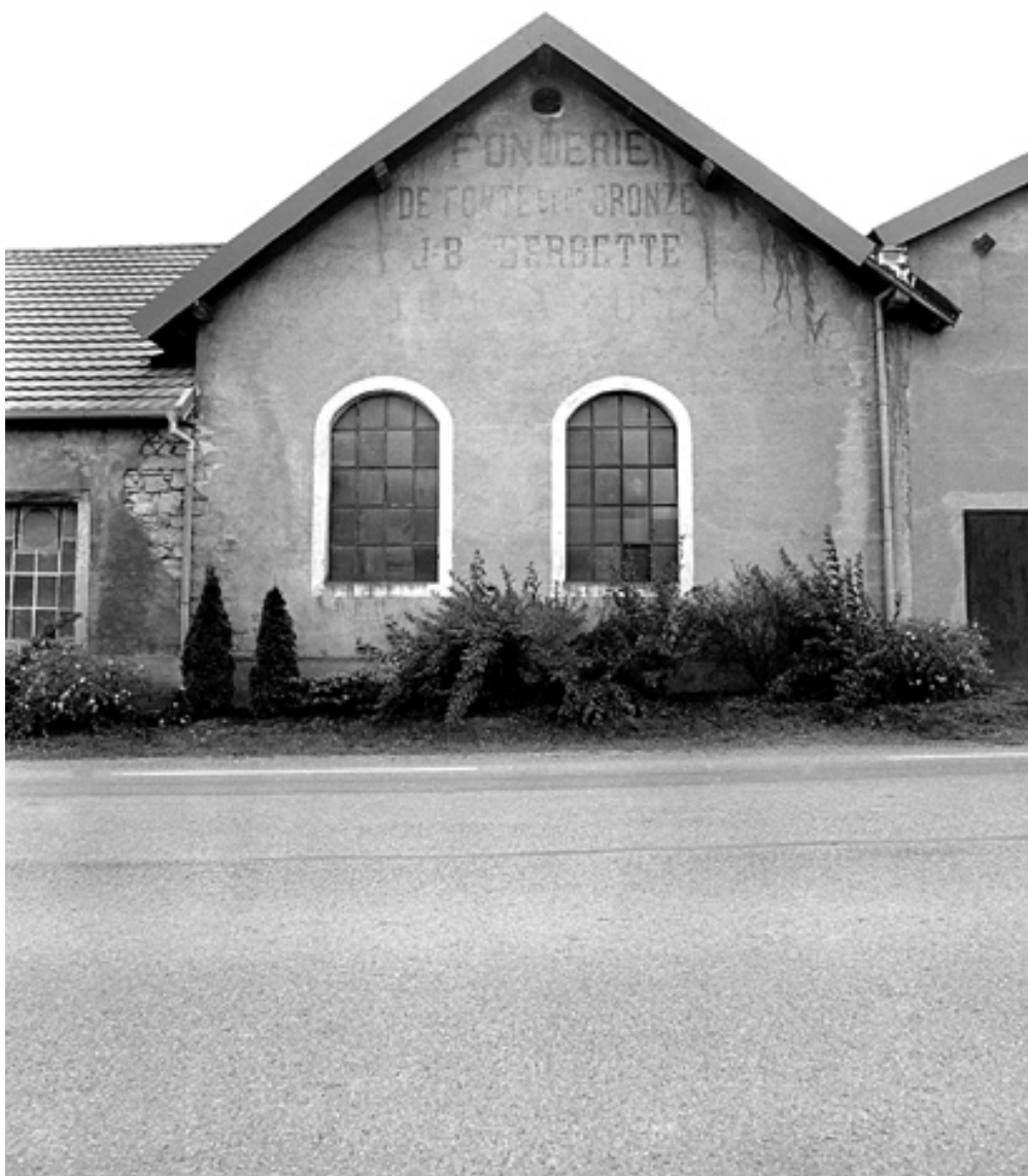
Mur-pignon d'un atelier de fabrication.
