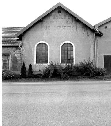
Mur-pignon d'un atelier de fabrication.
