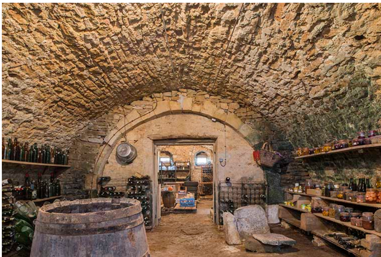
La cave voutée, vue générale.
