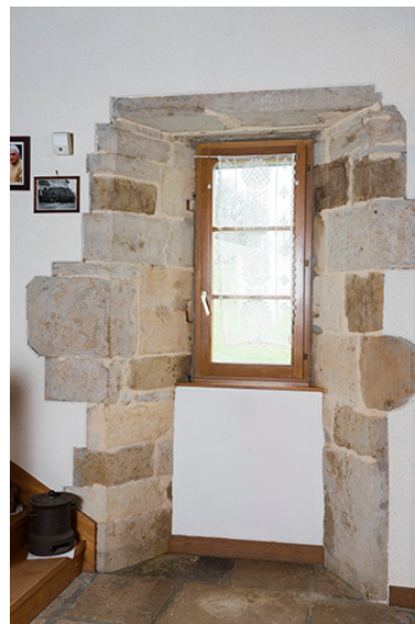
Encadrement d'une fenêtre, salle à manger. Phot. Jérôme Mongreville IVR43_20187000037NUC4A
