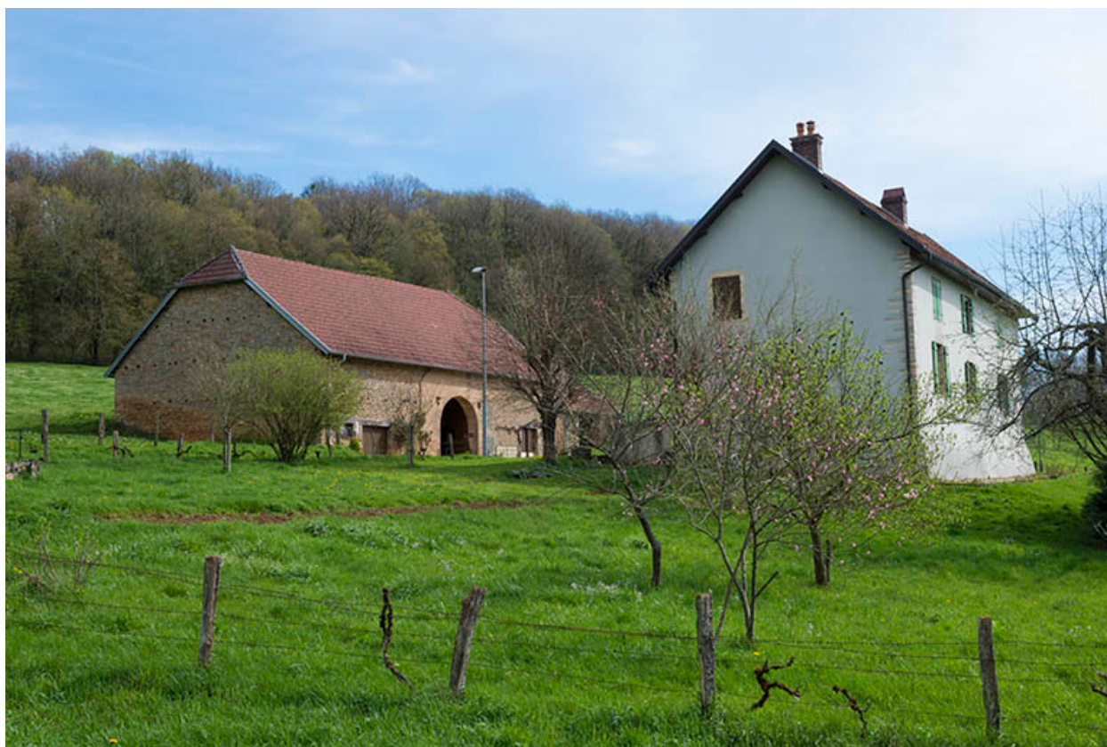
Vue depuis l'ouest.
