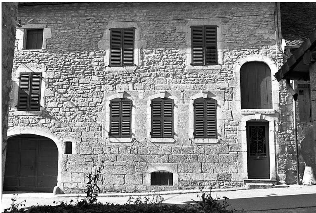
Maison de vigneron située à Mouthier-Haute-Pierre.
