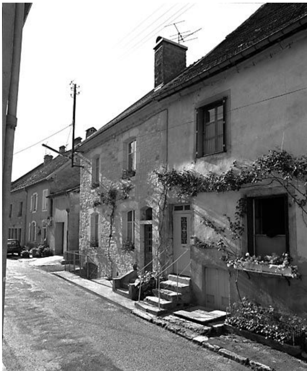
Maison de vigneron située à Vuillafans.
