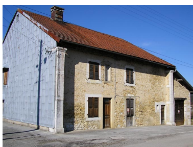
Ferme située au lieu- dit Les Chaumiers. Phot. Marie-Pierre Reynet IVR43_20083900490NUC1A
