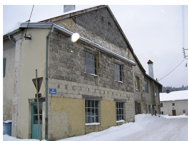
Maison située 18 rue Principale. Phot. Marie-Pierre Reynet IVR43_20083900497NUC1A
