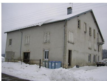
Maison située 50 rue Principale. Phot. Marie-Pierre Reynet IVR43_20083900493NUC1A
