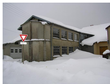
Maison située 18 rue Principale : ancien atelier. Phot. Marie-Pierre Reynet IVR43_20083900499NUC1A
