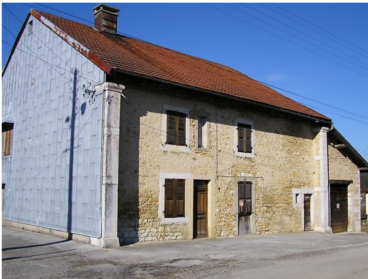
Ferme située au lieu-dit Les Chaumiers.
