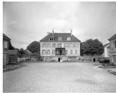
Habitation : façade antérieure de face. Phot. Yves Sancey IVR43_19887000091V
