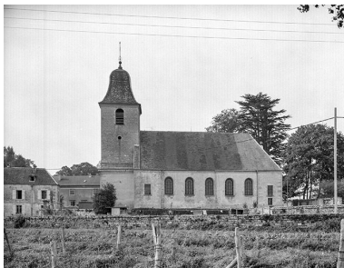
Face latérale droite. Phot. Yves Sancey IVR43_19757000135V
