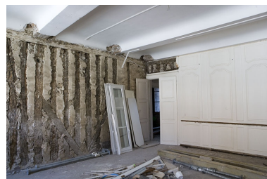
Intérieur, premier étage : détail d'un mur d'une pièce avec les lambris déposés. Phot. Yves Sancey IVR43_20072500686NUCA
