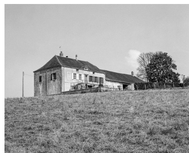
Ferme de vigneron située chemin de Montard : vue d'ensemble. Phot. Yves Sancey IVR43_19843900296X
