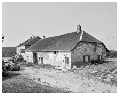
Ferme de vigneron située chemin de Montard : vue de trois quarts droit. Phot. Yves Sancey IVR43_19843900297X
