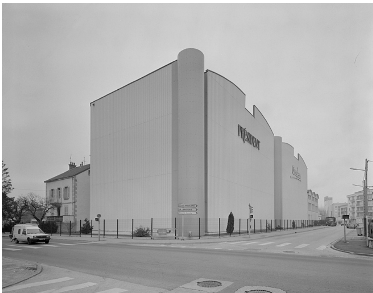
Magasin et entrepôt industriels.
