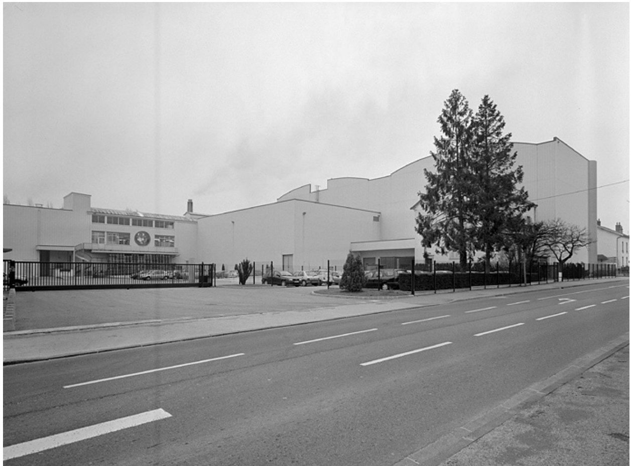
Vue d'ensemble depuis l'avenue Camille Prost.
