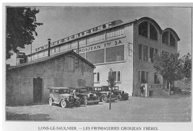
Lons-le-Saunier - Les Fromageries Grosjean Frères. Phot. Jérôme Mongreville IVR43_19963901199X
