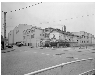
Vue d'ensemble depuis le nord- est. De gauche à droite : magasin et entrepôt industriels, atelier de fabrication et de conditionnement, chaufferie et vestiaire. Phot. Jérôme Mongreville IVR43_19963901878V
