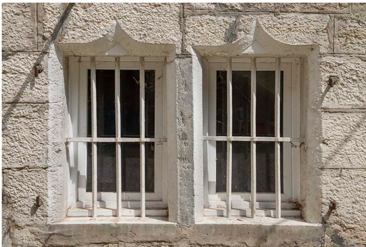
Façade est. Ouvertures du rez-de-chaussée.
