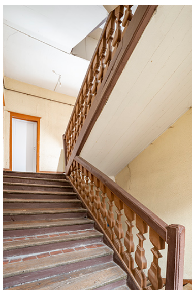
Escalier (n°3). Vue depuis le premier étage.
