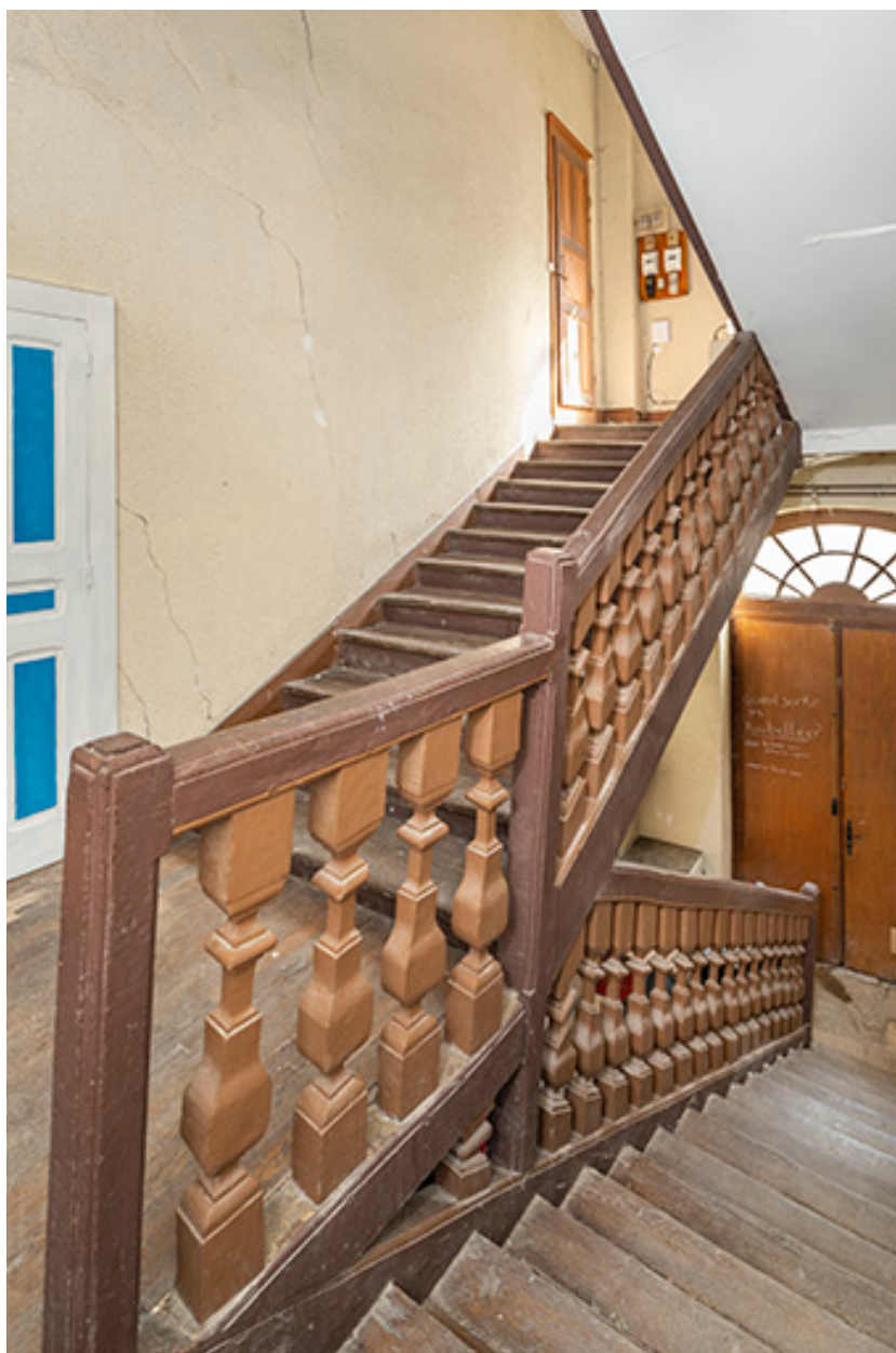
Escalier (n°3). Vue depuis l'entresol.
