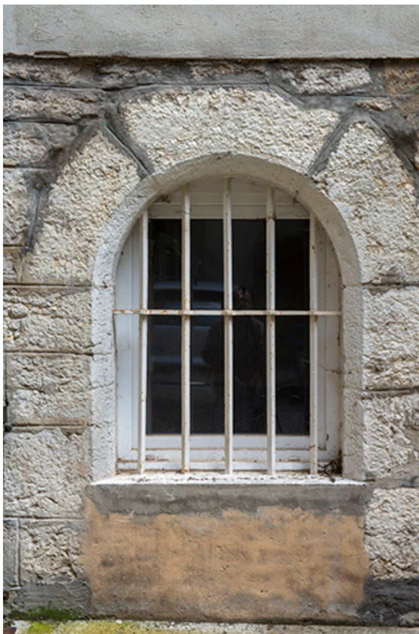
Façade est. Baie en plein-cintre du rez-de-chaussée.
