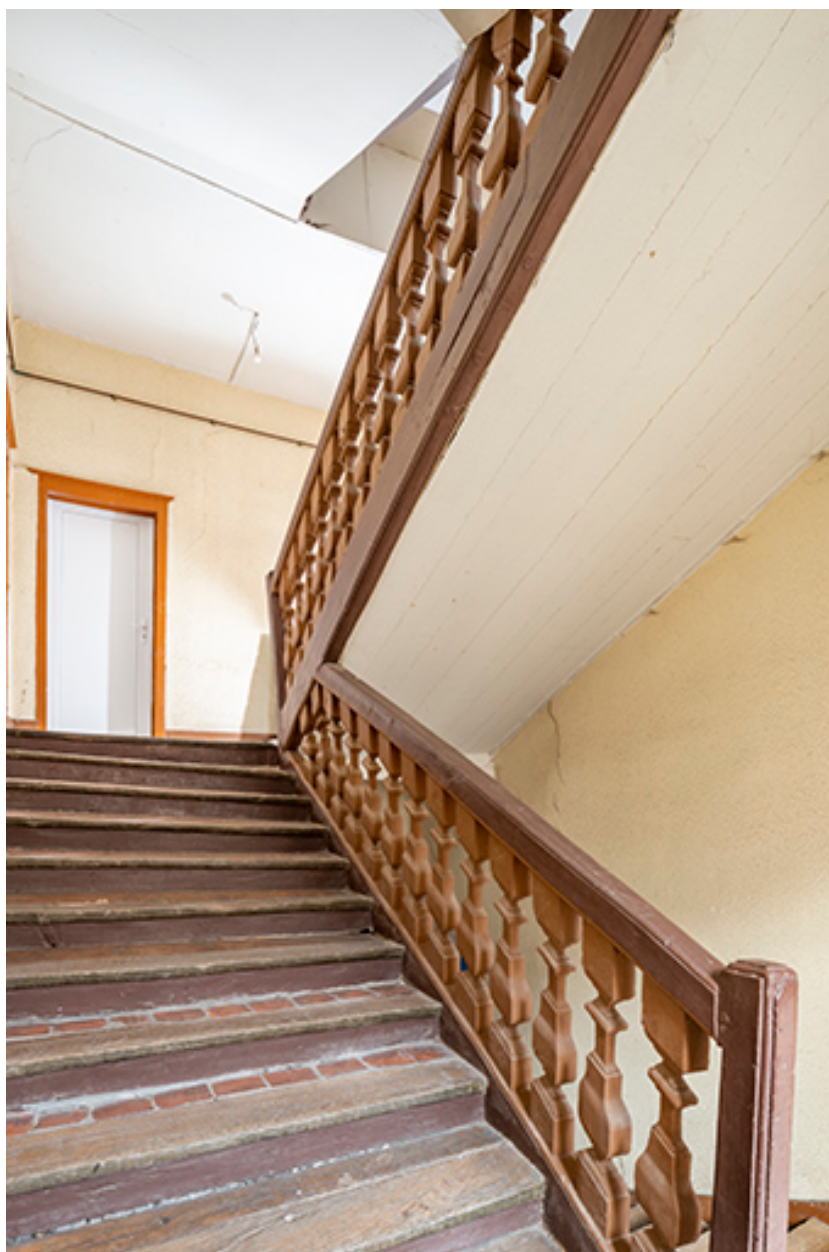
Escalier (n°3). Vue depuis le premier étage.
