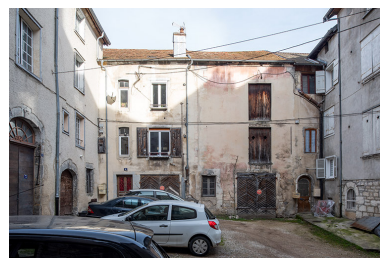
Vue d'ensemble depuis le sud. Phot. Nicolas Waltefaugle IVR43_20263900061NUC4A
