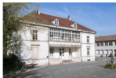
Façade est vue de trois quarts gauche. Phot. Jérôme Mongreville IVR43_20132500269NUC4A
