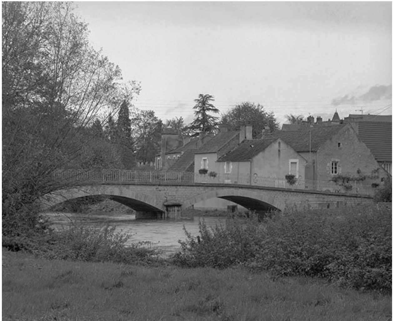
Vue d'ensemble prise de l'amont.
