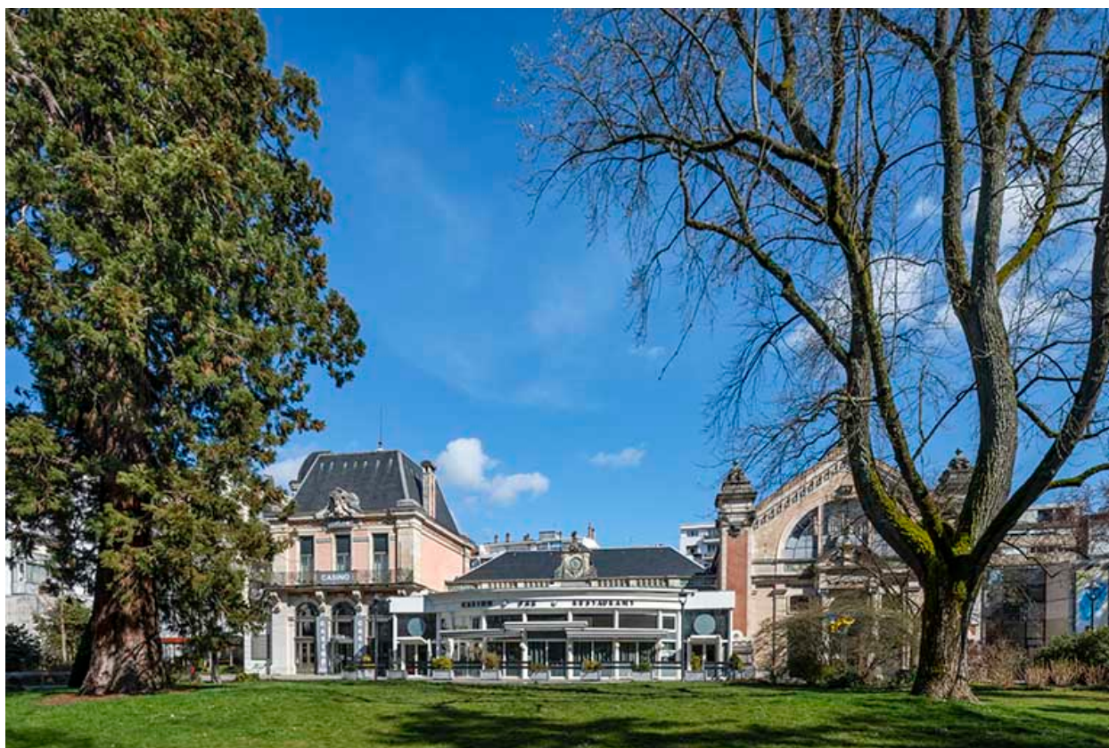
Situation de l'édifice depuis l'avenue Édouard Droz.
