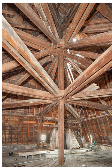
Charpente du pavillon ouest. Phot. Jérôme Mongreville IVR43_20232500391NUC4A
