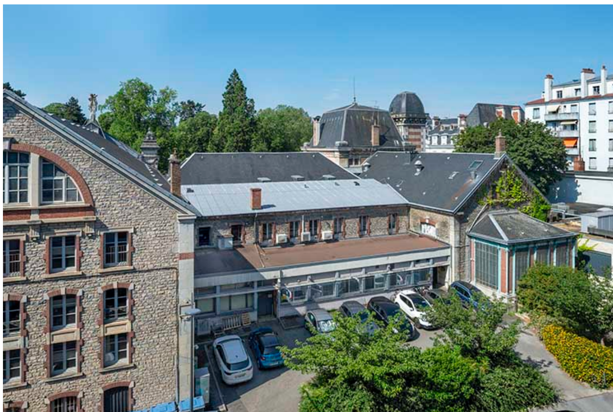
Façade sur la rue de la Mouillère.
