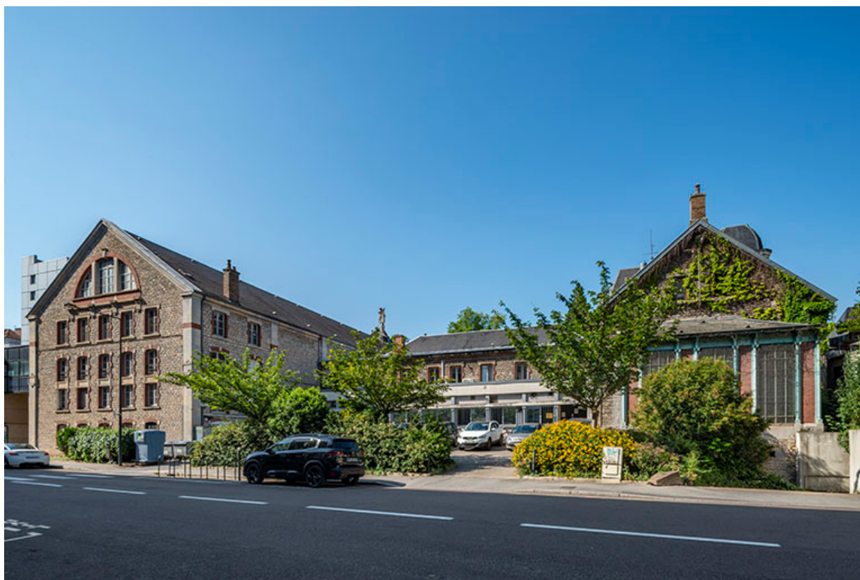
Façade sur la rue de la Mouillère.
