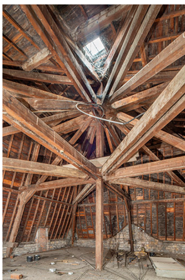
Charpente du pavillon ouest. Phot. Jérôme Mongreville IVR43_20232500390NUC4A
