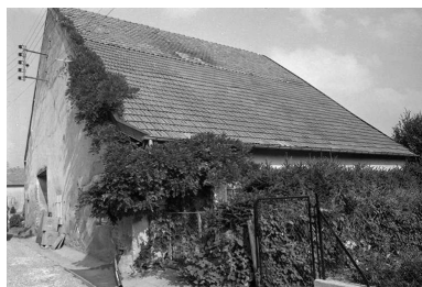
Maison située rue de l'Eglise. Phot. Gilbert Poinot IVR43_19762500919Z
