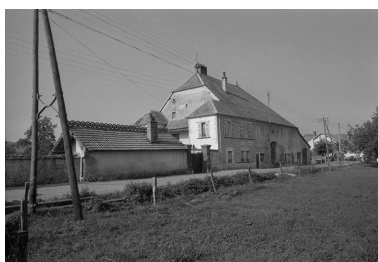
Ferme située 1-3 rue de Merey. Phot. Gilbert Poinot IVR43_19762500894Z
