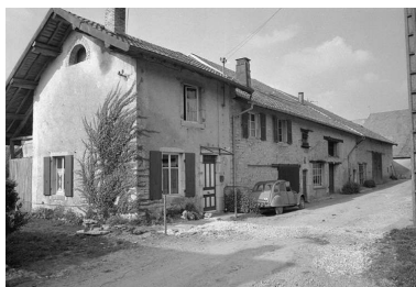
Maison située rue de l'Eglise Phot. Gilbert Poinot IVR43_19762500918Z
