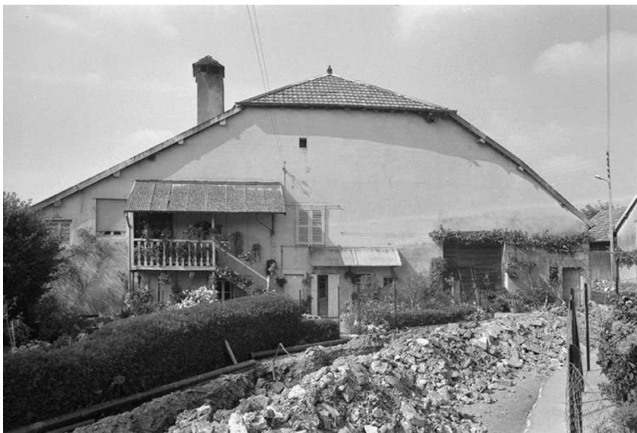
Ferme située route de Naglans.
