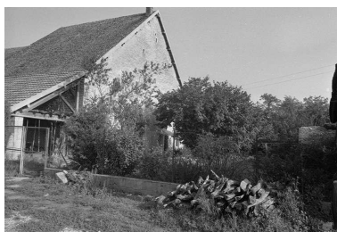
Ferme située 12 rue de Merey. La partie gauche correspondant à l'avant-toit a été détruite après 1976. Phot. Gilbert Poinot IVR43_19762500891Z
