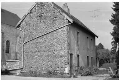
Maison située impasse Caramel. Phot. Gilbert Poinot IVR43_19762500907Z
