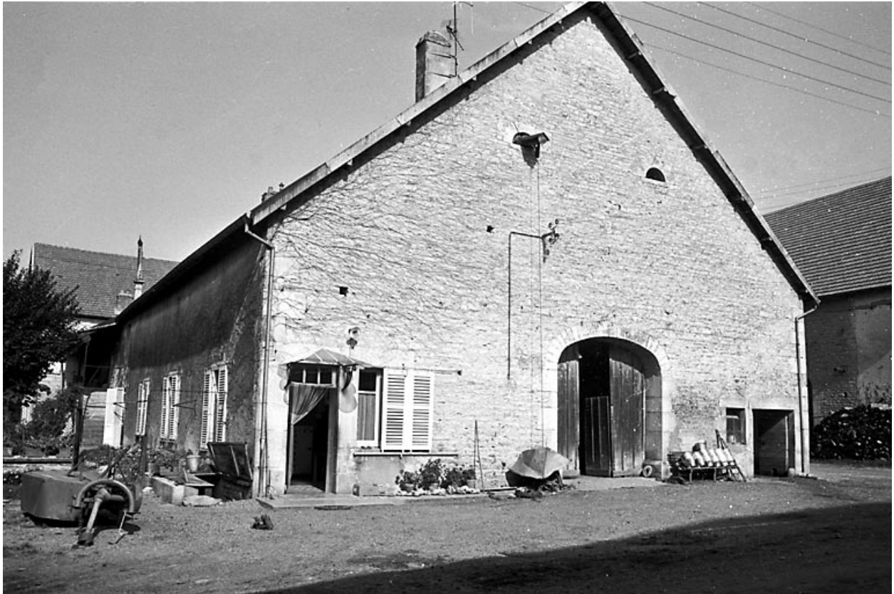
Ferme située 5 rue de Tarcenay.
