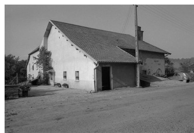
Ferme située 7 rue de Merey. Phot. Gilbert Poinot IVR43_19762500892Z
