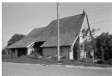
Ferme située 12 rue de Merey. La partie gauche correspondant à l'avant-toit a été détruite après 1976. Phot. Gilbert Poinot IVR43_19762500890Z
