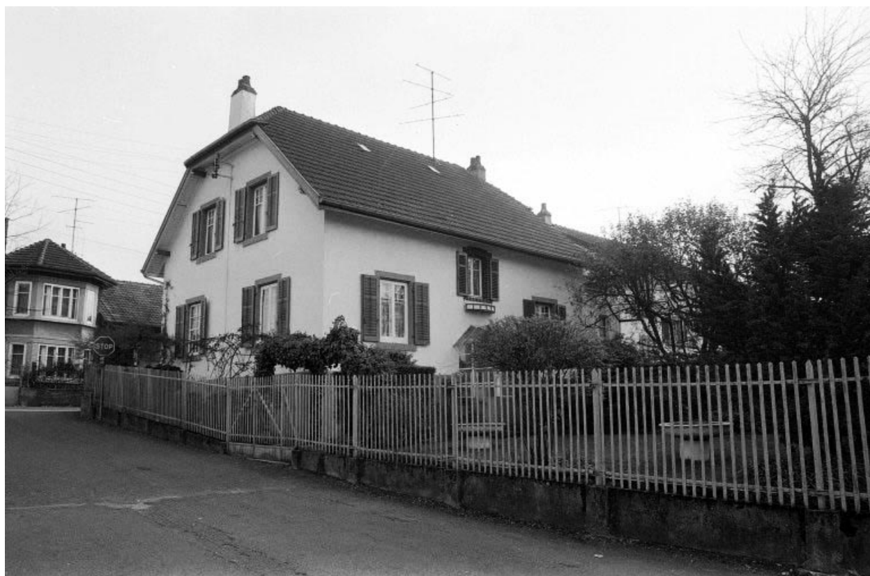
Façades postérieure et latérale droite.
