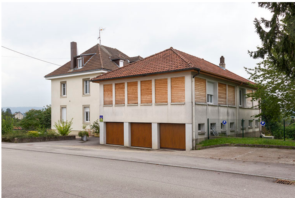
Usine : façades antérieure et latérale droite.
