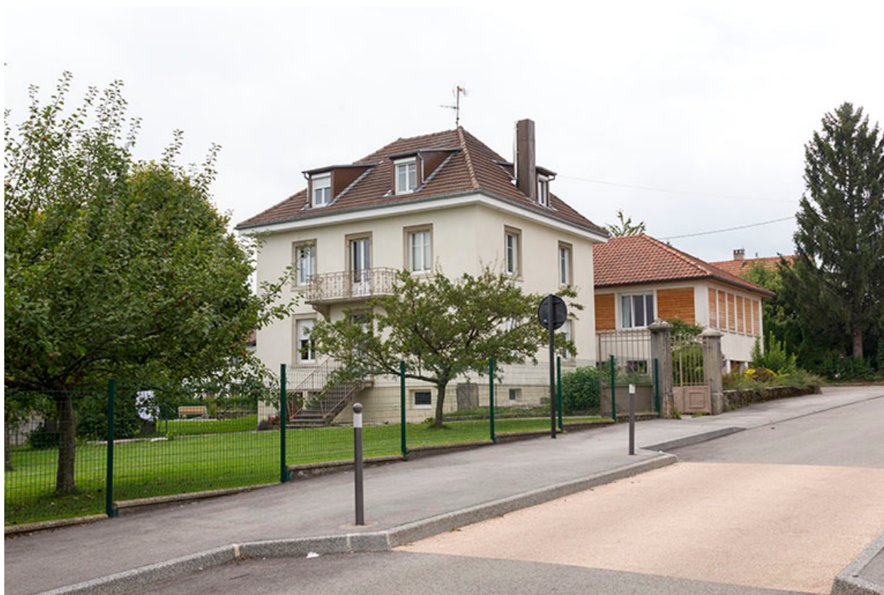
Vue d'ensemble du site, depuis l'est.
