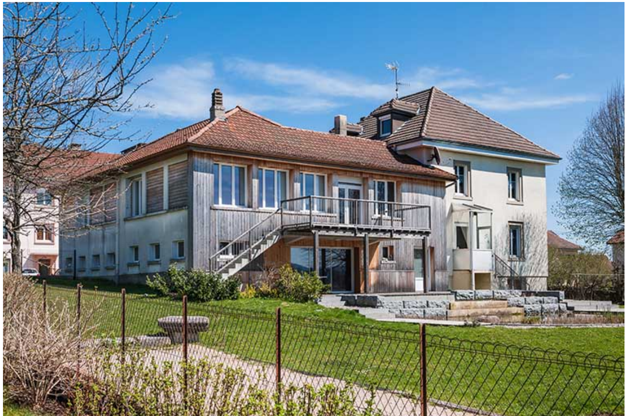
Usine : façades postérieure et latérale droite.
