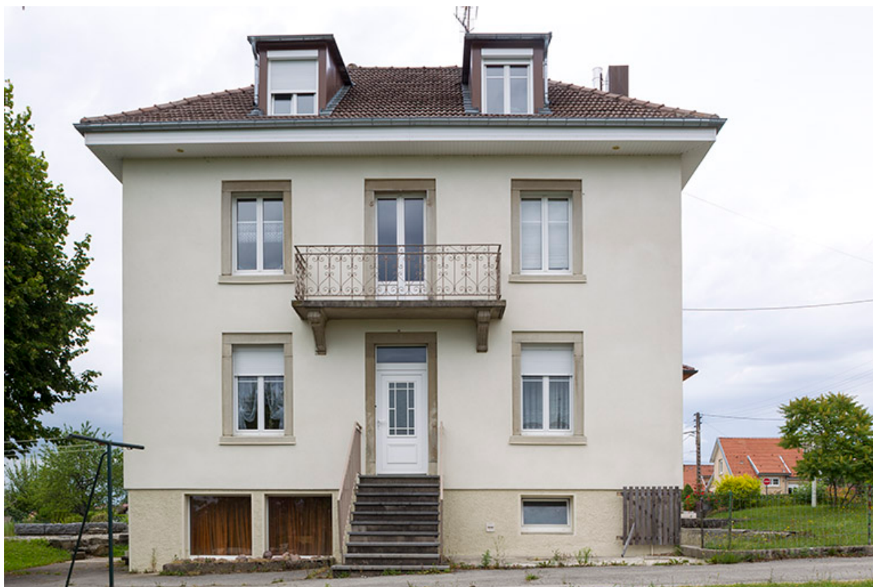
Logement patronal : façade latérale droite.
