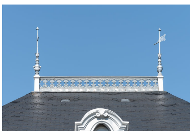
Crête et épis de faîtage.
