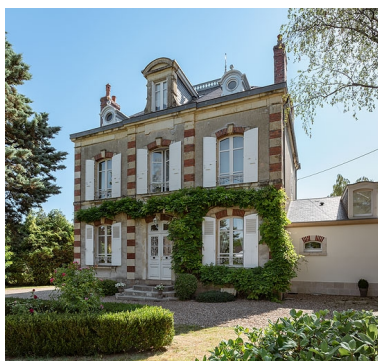
Façade sur l'avenue. Phot. Pierre-Marie Barbe-Richaud IVR26_20205800536NUC4AQ
