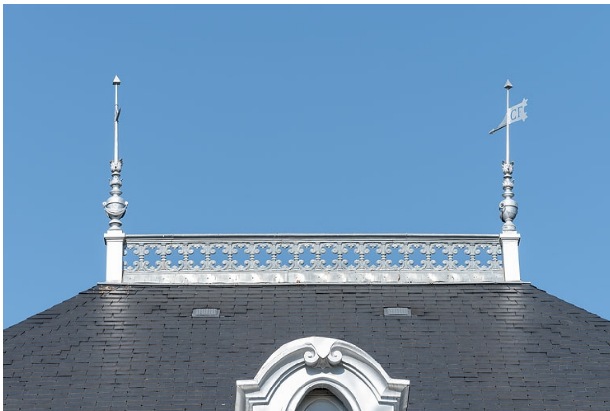
Crête et épis de faîtage.
