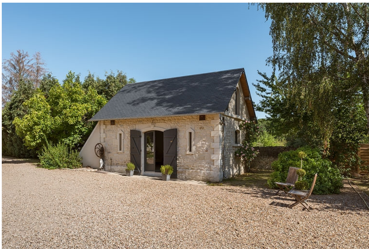
Dépendance (remise-écurie) côté nord.
