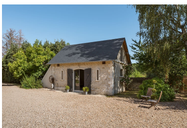
Dépendance (remise-écurie) côté nord.
