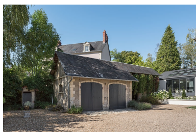
Dépendance (remise-écurie) côté sud.
