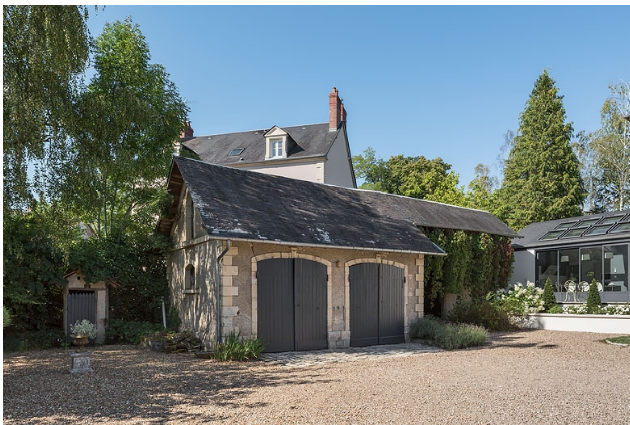
Dépendance (remise-écurie) côté sud.
