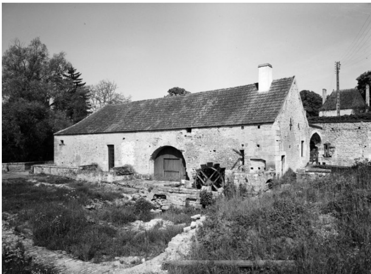
Bâtiment de la fenderie, élévation est.
