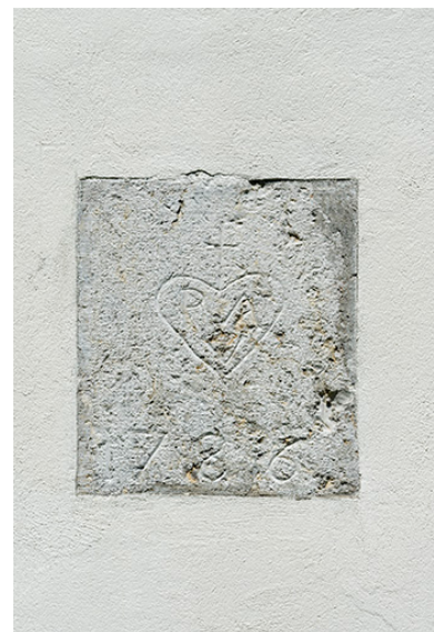
Date 1786 portée (élévation sud-est). Phot. Sonia Dourlot IVR43_20172500879NUC4A
