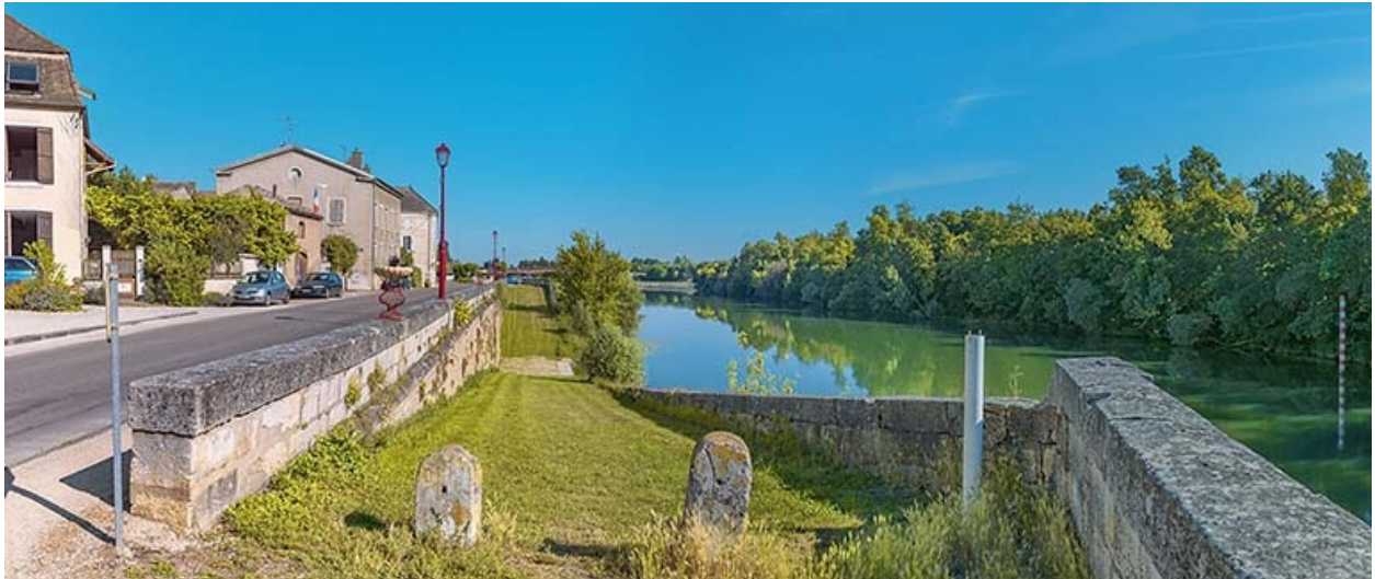
Quais de Verdun : la double rampe.
