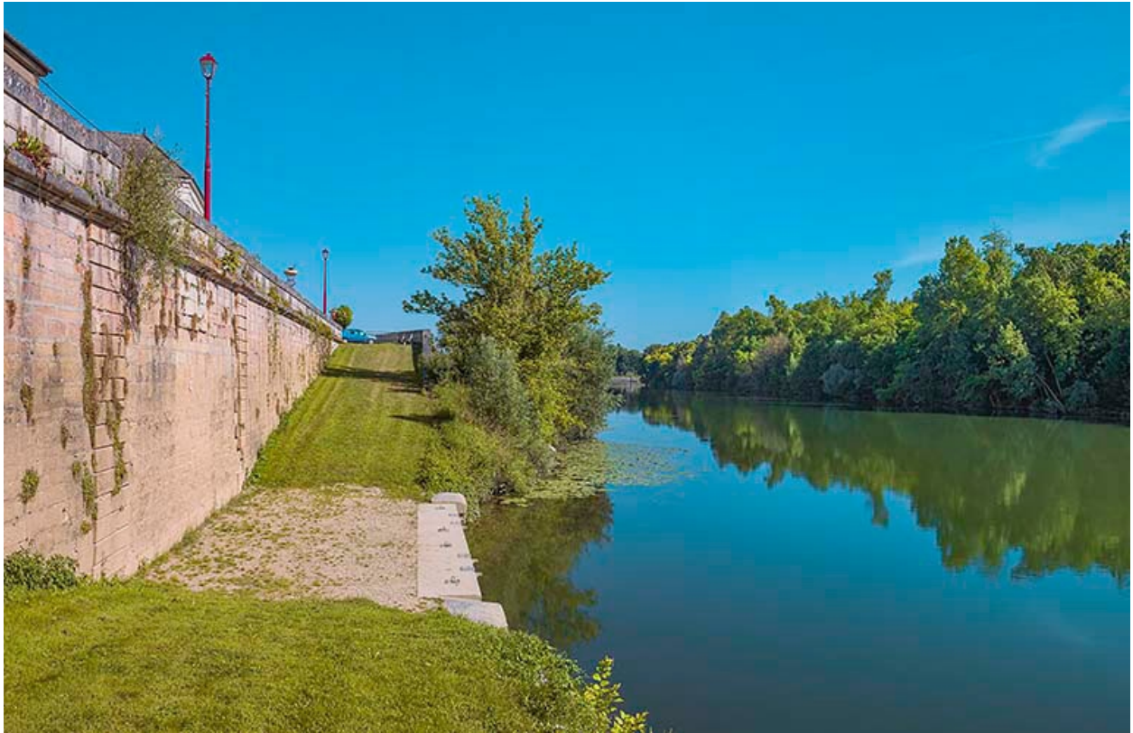
Quais de Verdun : la double rampe.
