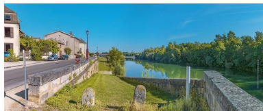
Quais de Verdun : la double rampe.
