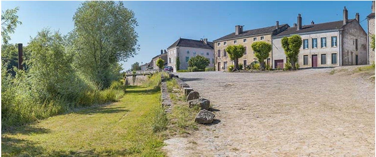
Les quais vus d'aval.
