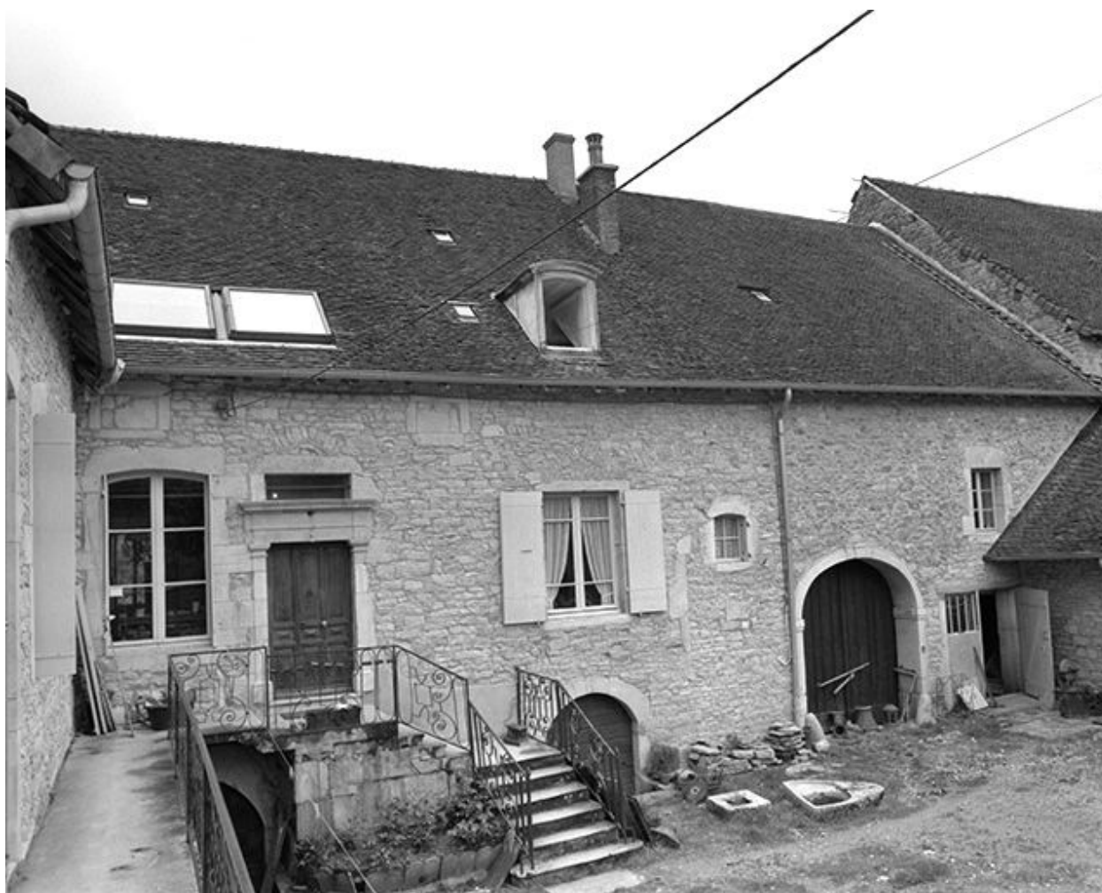
Ferme de vigneron située rue du Château.
