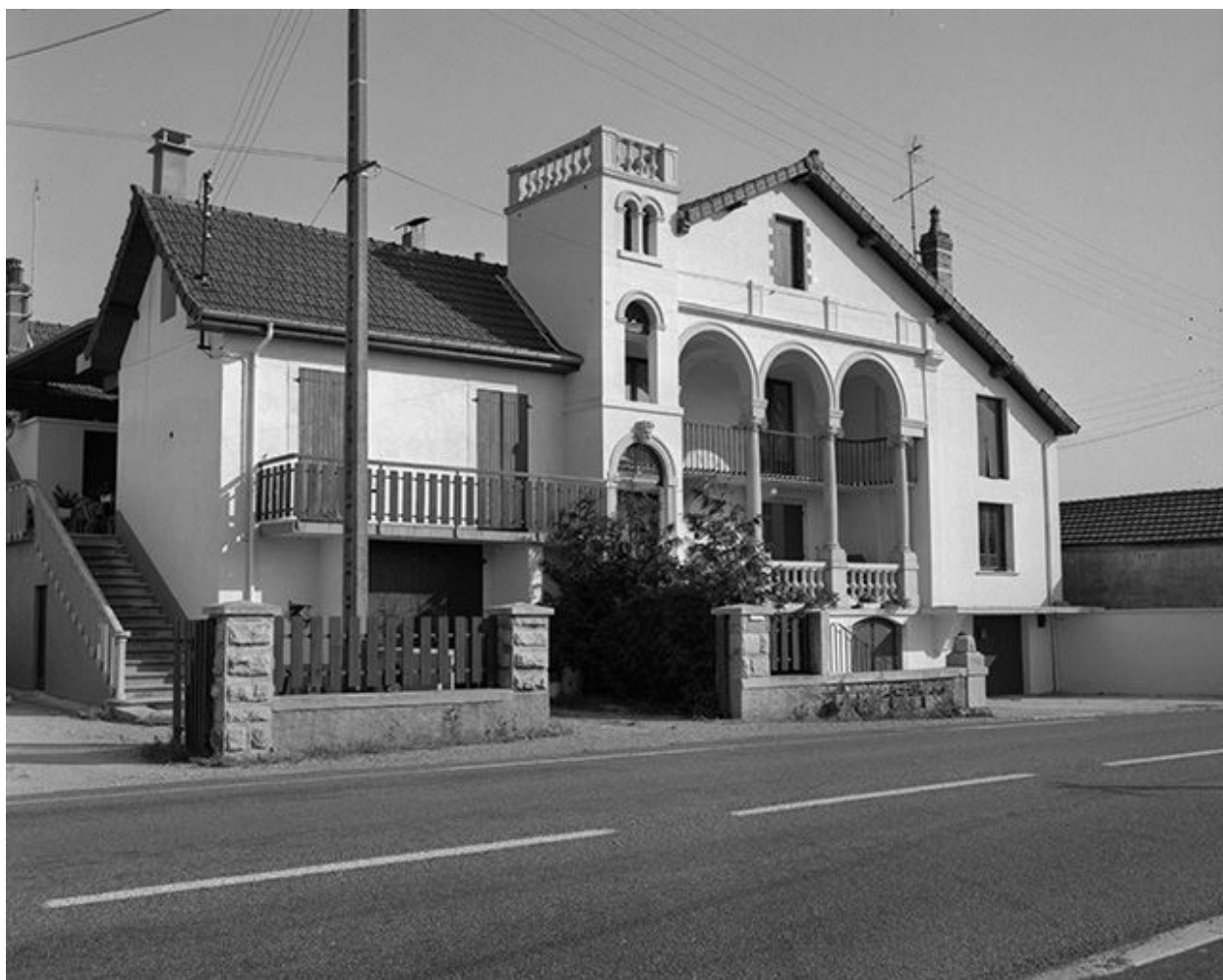
Maison située route de Lons-le-Saunier.
