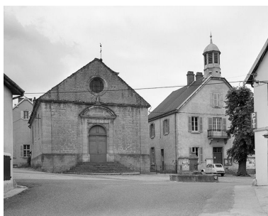
Mairie et église paroissiale Saint-Léger. Phot. Yves Sancey IVR43_19853900205V
