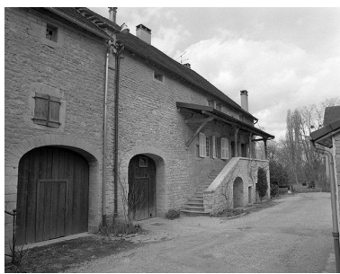
Ferme de vigneron située impasse de la Bourcette. Phot. Jérôme Mongreville IVR43_19853900099X
