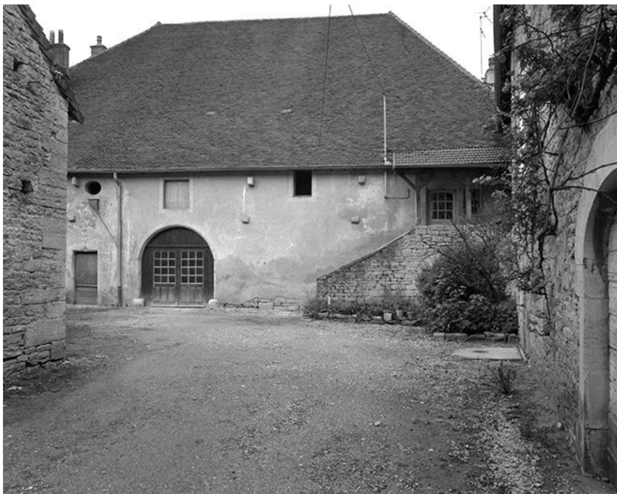
Demeure dite le Caveau située rue du Château.
