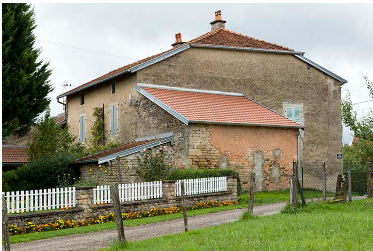
Ferme transformée en maison.
