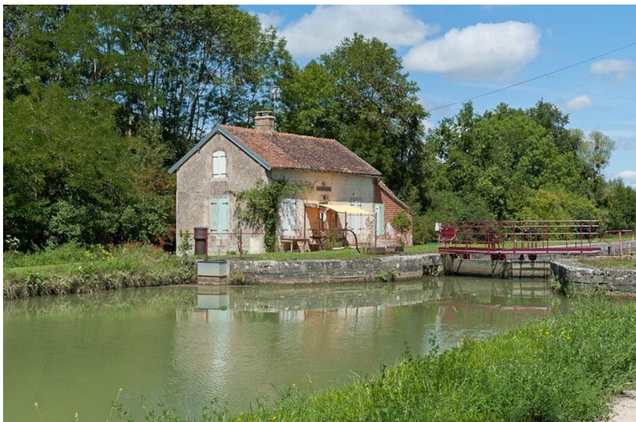
Vue du site d'écluse depuis l'amont.
