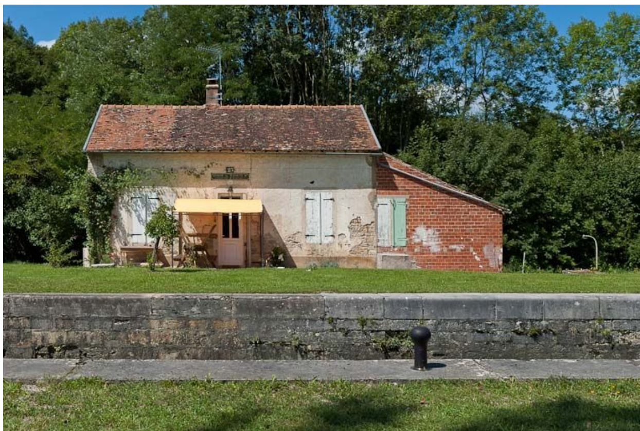
Vue de face de la maison éclusière.
