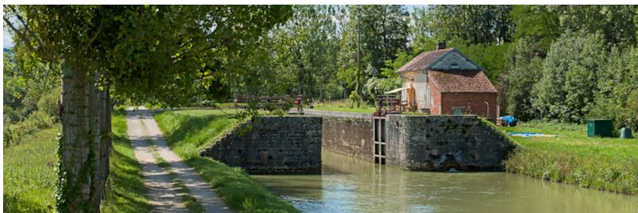
Vue du site d'écluse depuis l'aval.
