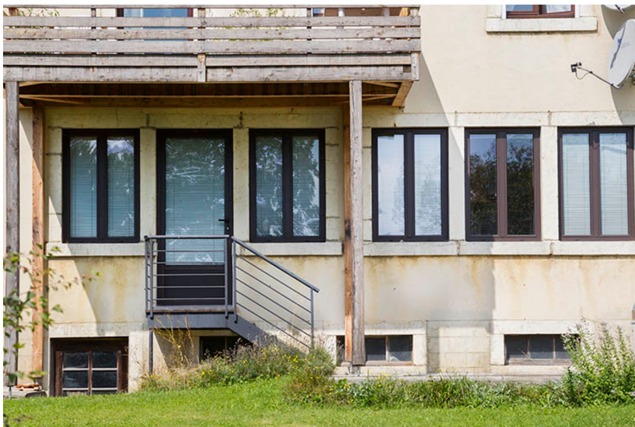
Façade postérieure : fenêtres de l'atelier.
