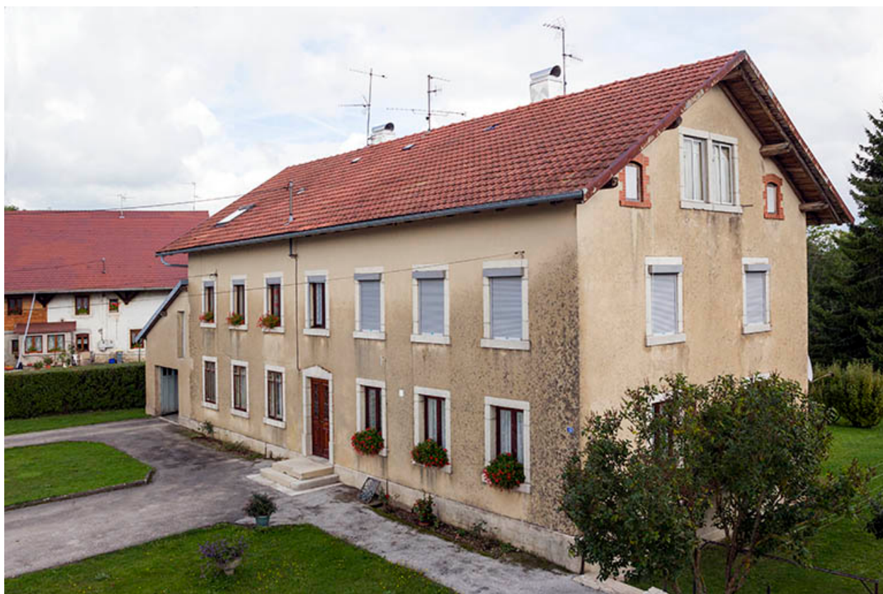
Façades antérieure et latérale droite.
