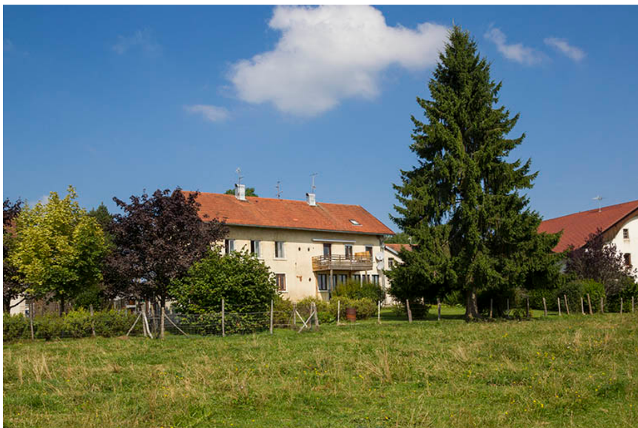
Vue d'ensemble, depuis l'est (façade postérieure).
